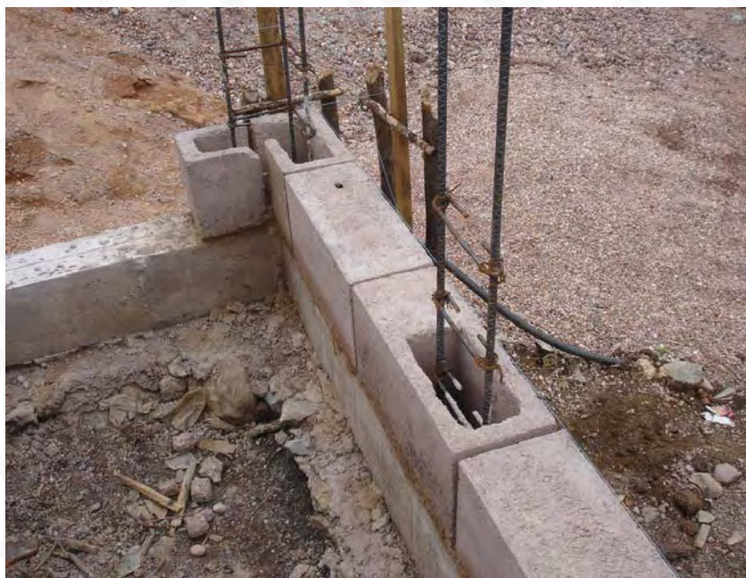
Castillo C-L y C-I con piezas especiales
