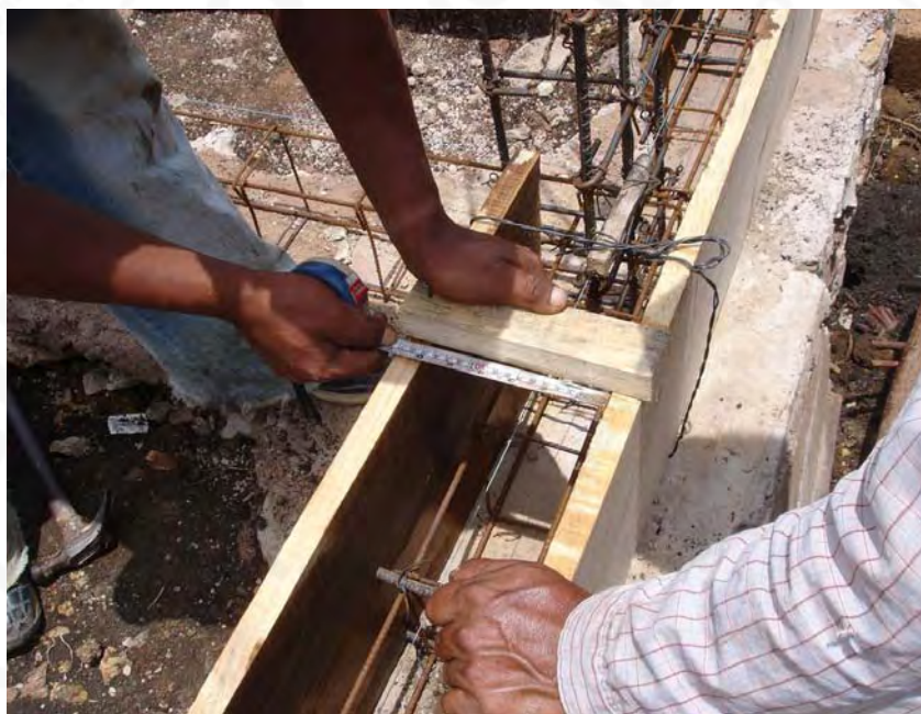
Colocación de separadores en cimbra de cadena
