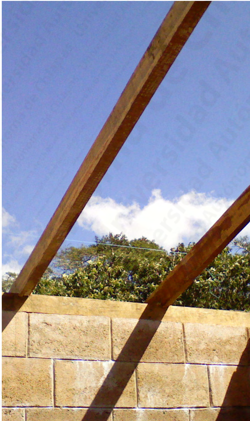
Barrotes anclados en cadena de cerramiento CC-2
