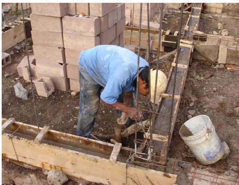
Picado de concreto en cadena de desplante
