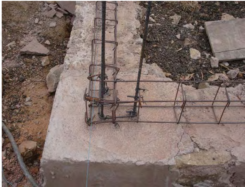
Cruce de cadena de desplante en castillo C-L
