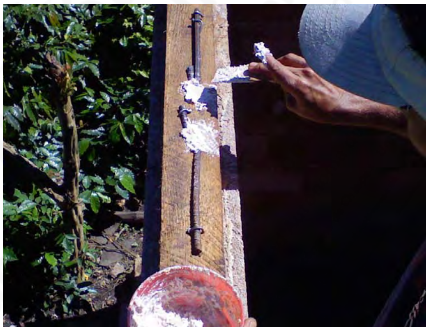
Relleno de aserrín y pegamento en oquedades de polín
