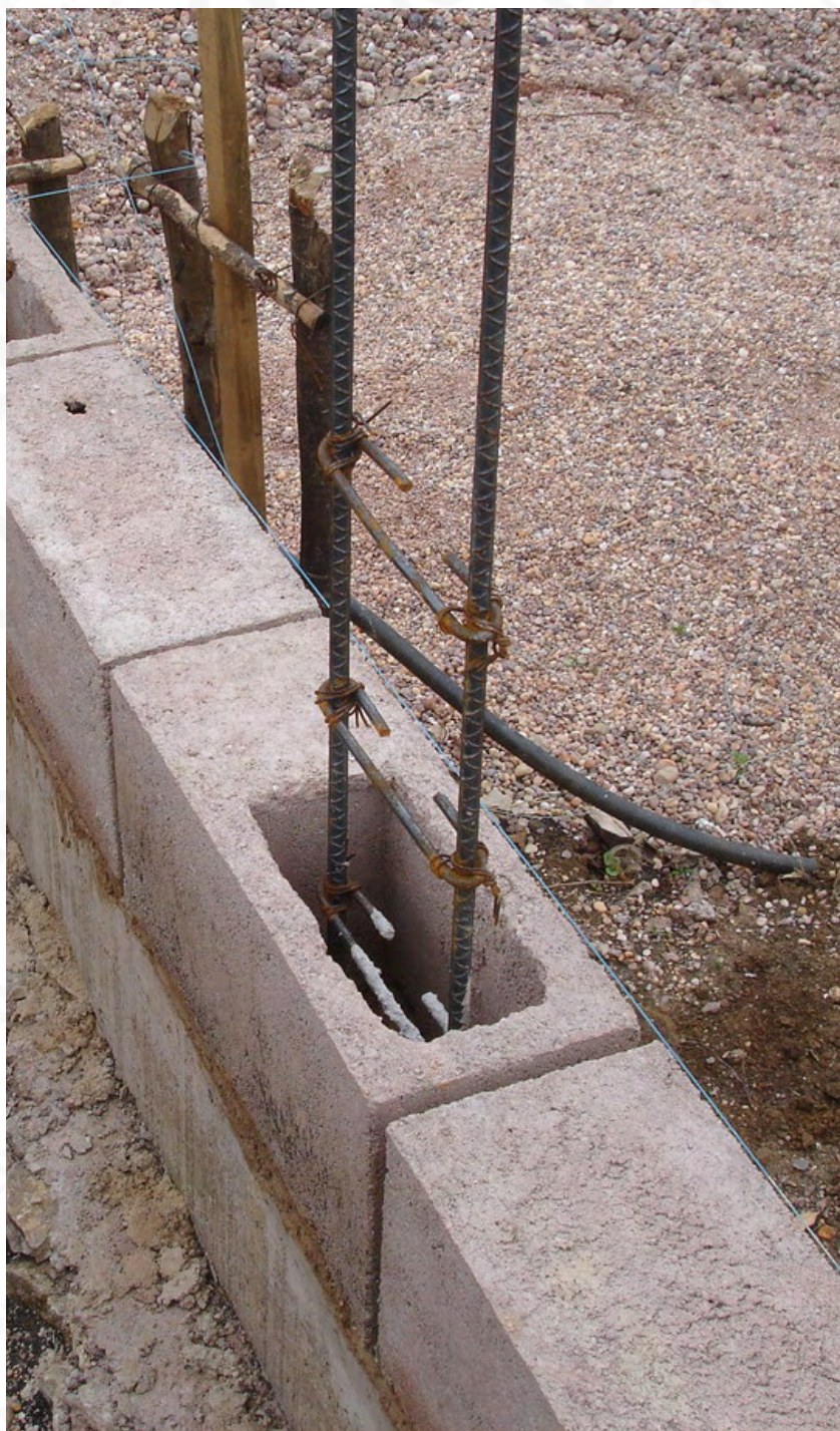
Castillo C-I encofrado con pieza especial B-7
