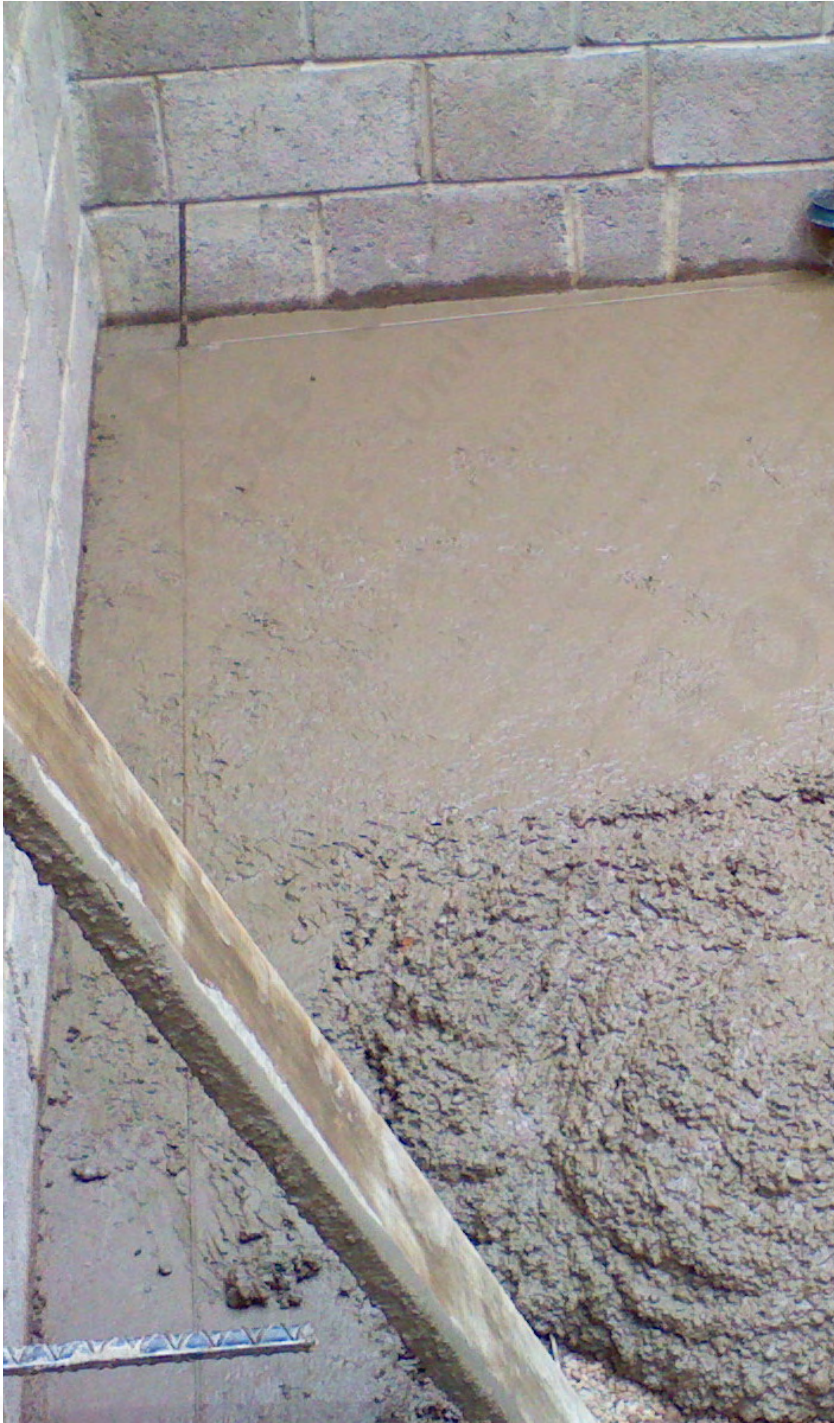
Concreto en firme
