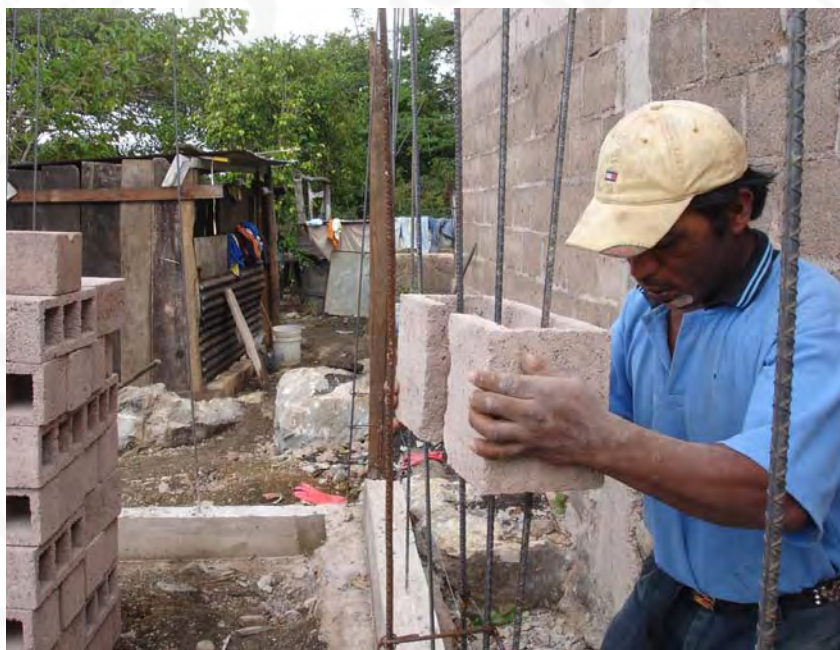
Colocación de pieza especial B-9 en castillo C-T
