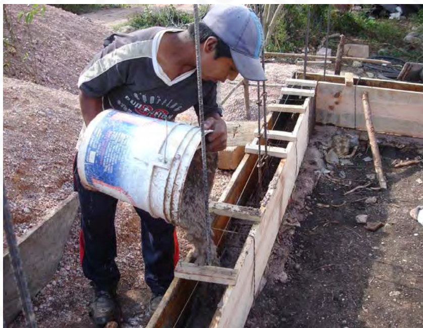
Colado de cadena de desplante
