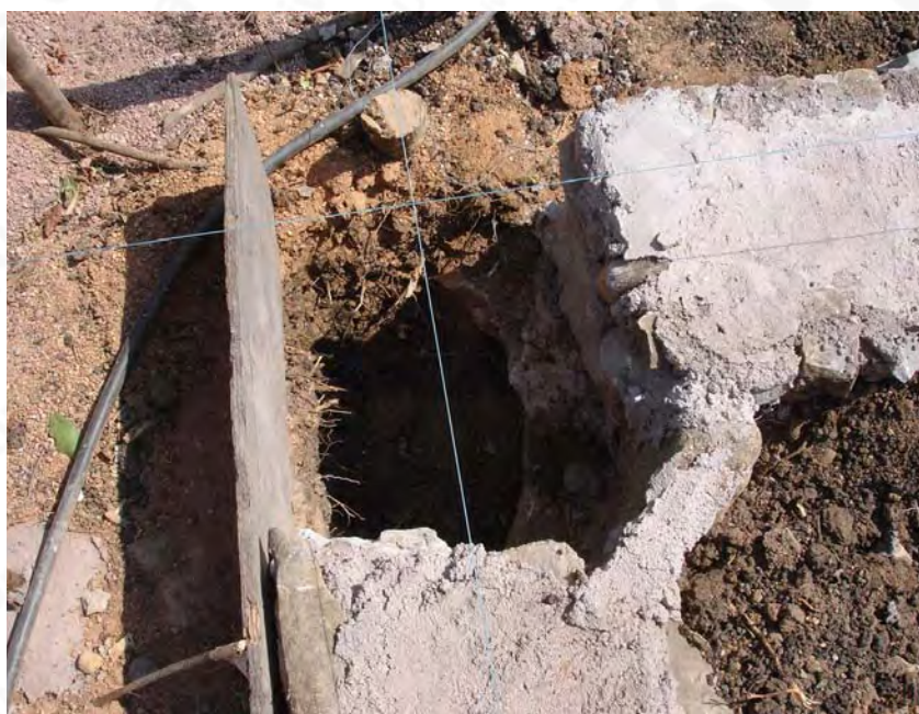
Preparación para anclar castillo C-L
