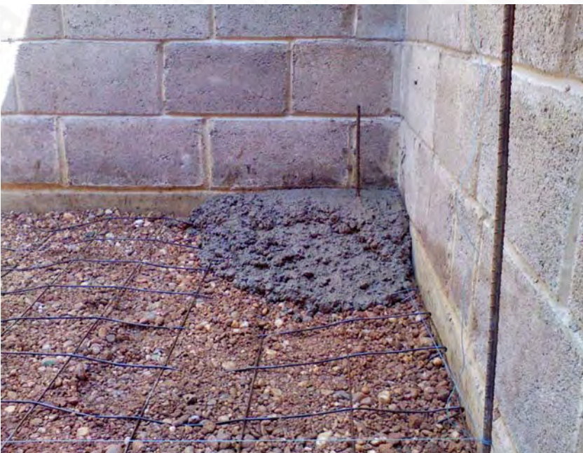
Tendido de concreto para firme
