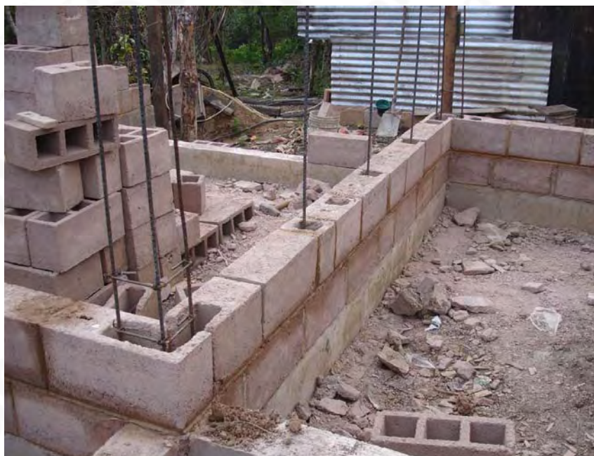
Primeras filas de block con castillos C-L y C-V
