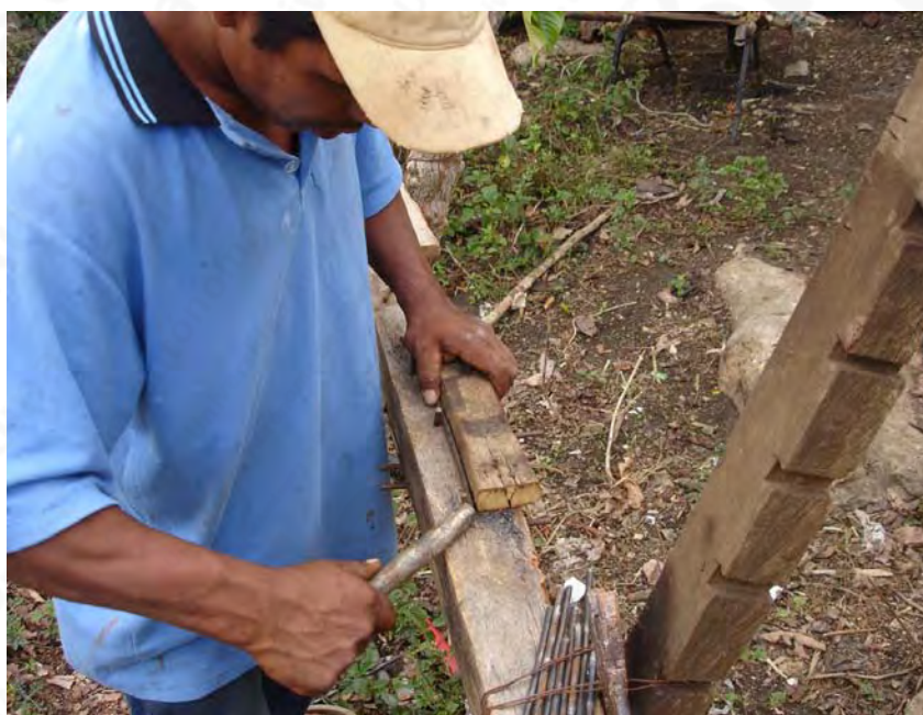
Preparación de estribos (Anillitas)
