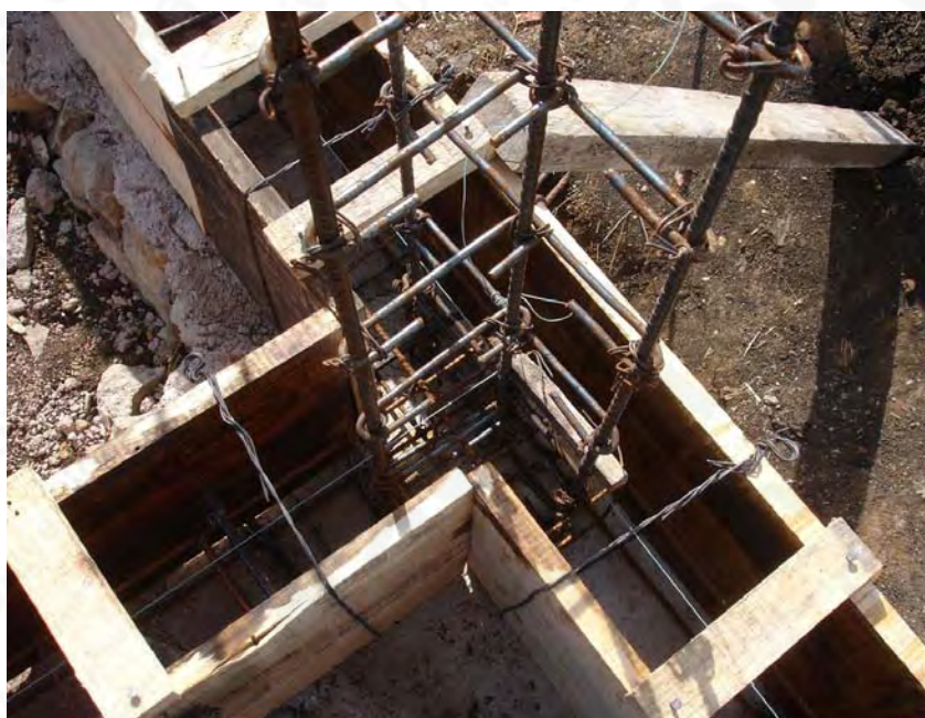
Cimbrado de cadena de desplante
