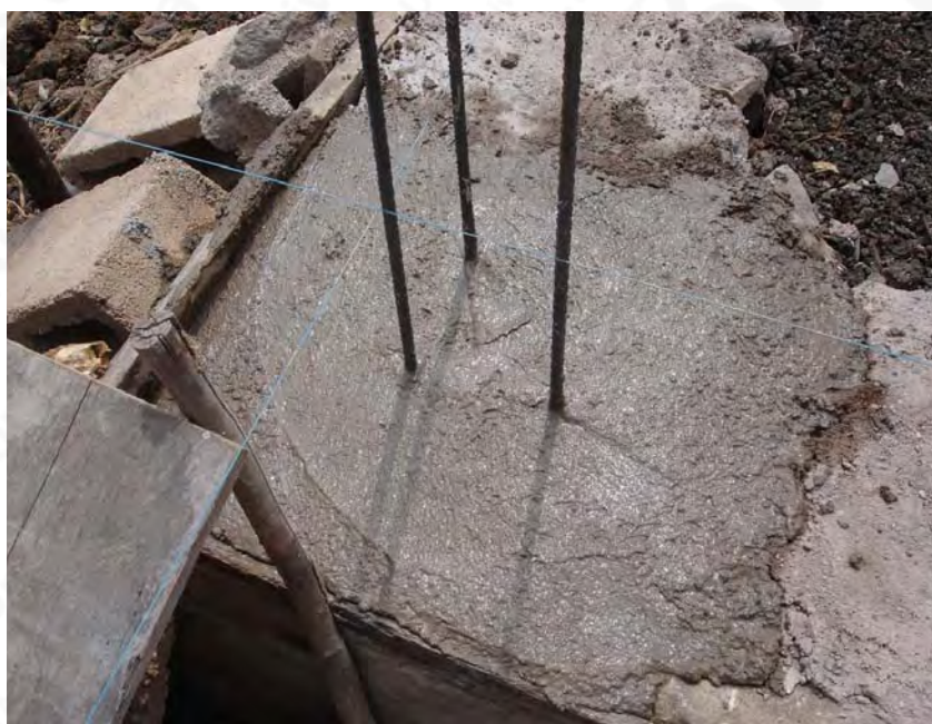
Castillo C-L colado completamente
