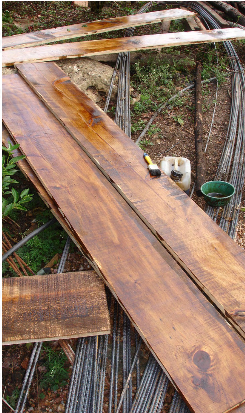
Cimbra de madera curada con aceite quemado
