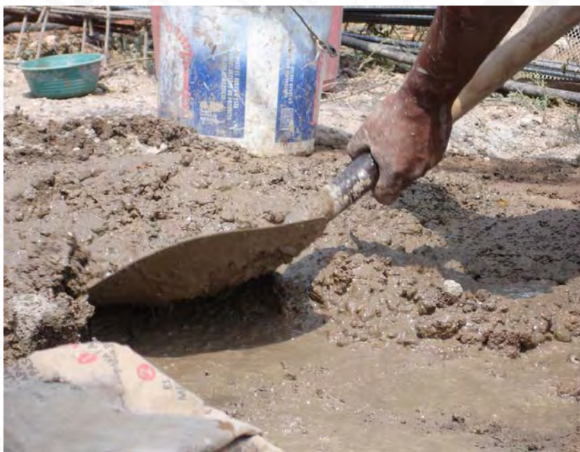
Mezcla para concreto
