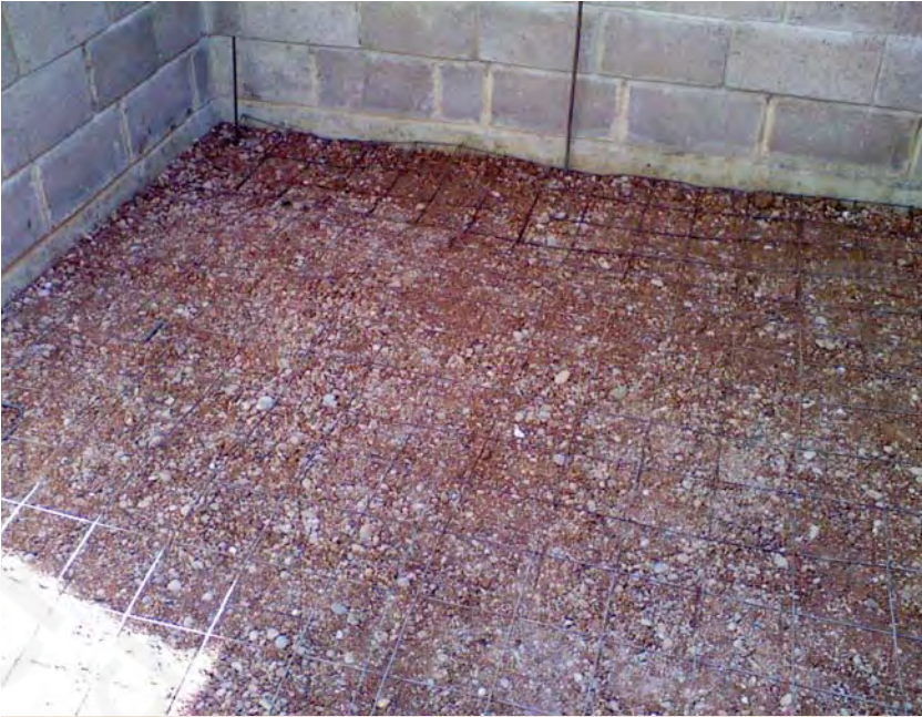
Colocación de malla electrosoldada para firme
