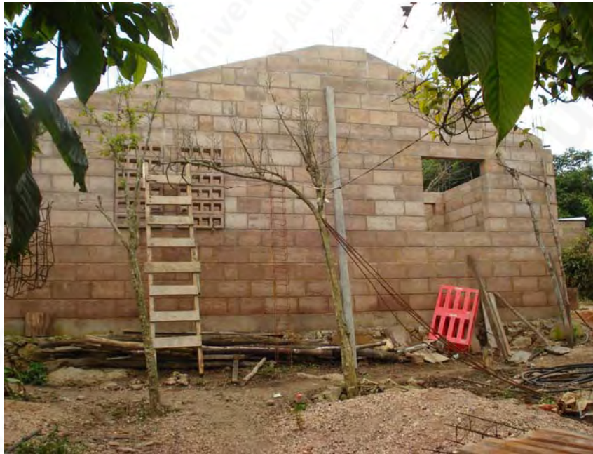
Muro lateral de la vivienda (Tímpano)
