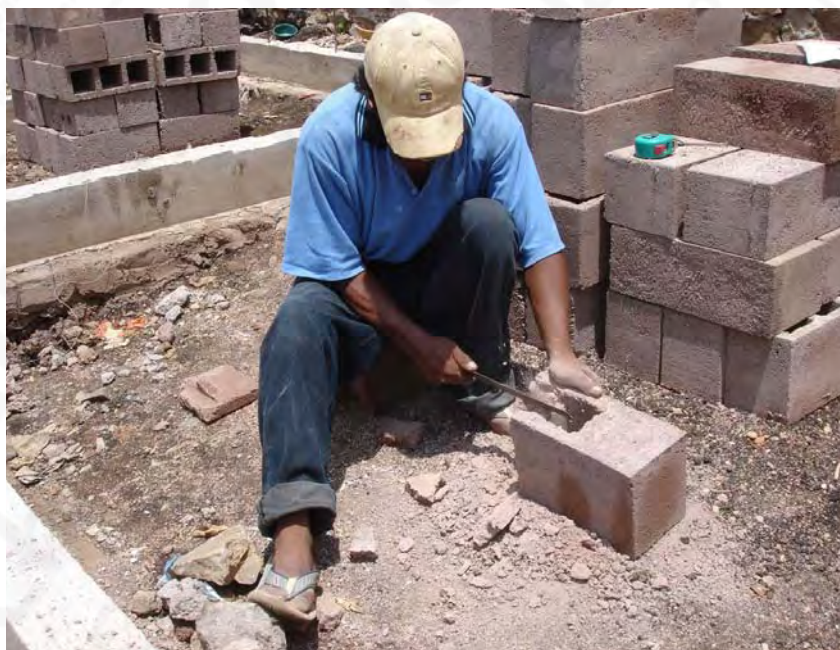
Elaboración de piezas especiales en seco (1)
