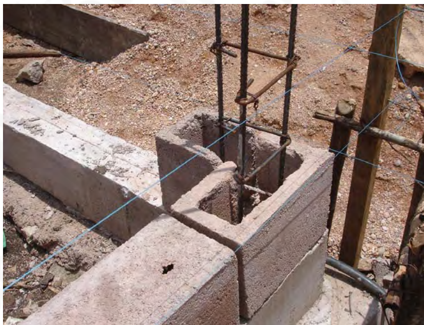
Castillo C-L encofrado con piezas especiales
