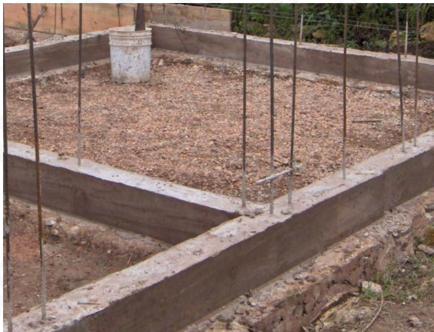
Cadena de desplante terminada
