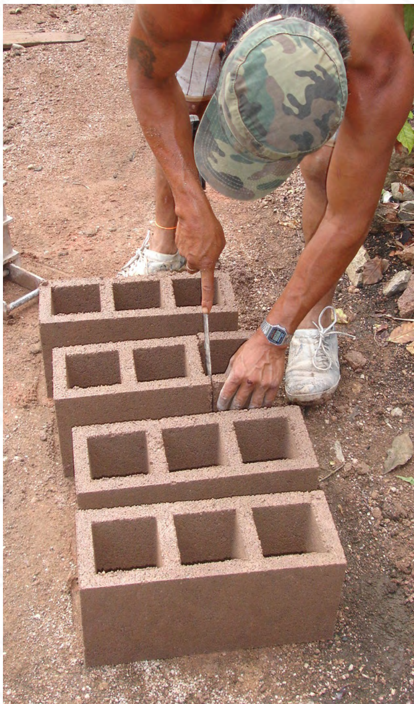
Corte de block en fresco para piezas especiales
