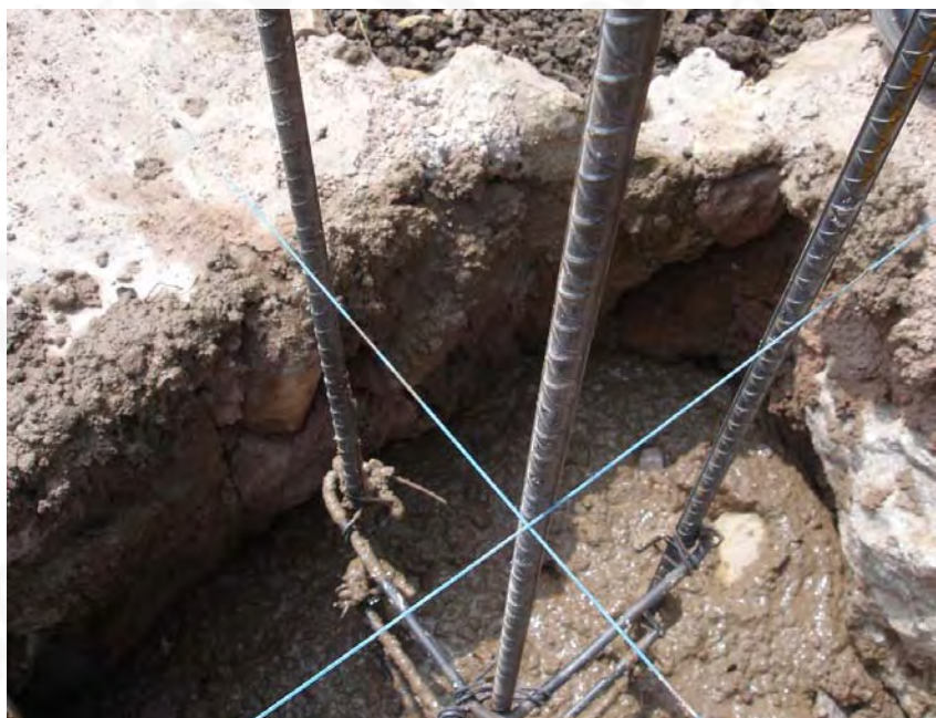
Correcto alineamiento de castillos basado en el hilo-reventón
