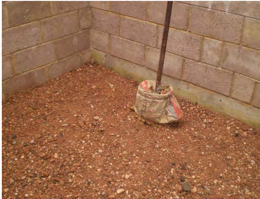
Compactación de relleno mejorado
