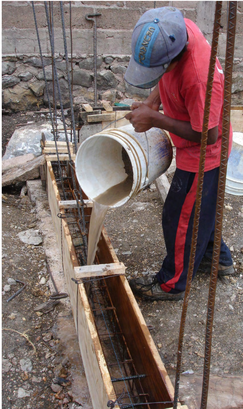
Mojado de cimbra
