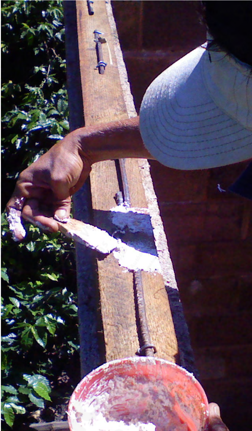
Relleno de aserrín y pegamento en oquedades de polín
