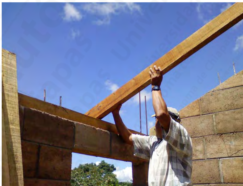
Colocación de barrotes en polín para tijera de estructura
