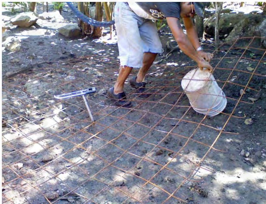
Preparación de malla electrosoldada 6-6/10-10 para firme
