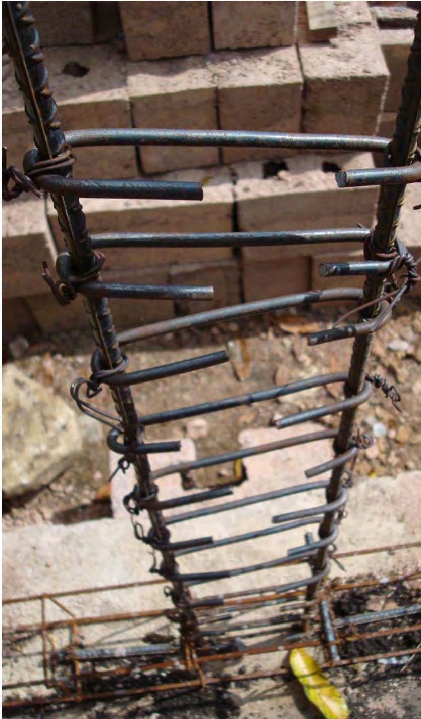
Refuerzo vertical (Castillo C-I)
