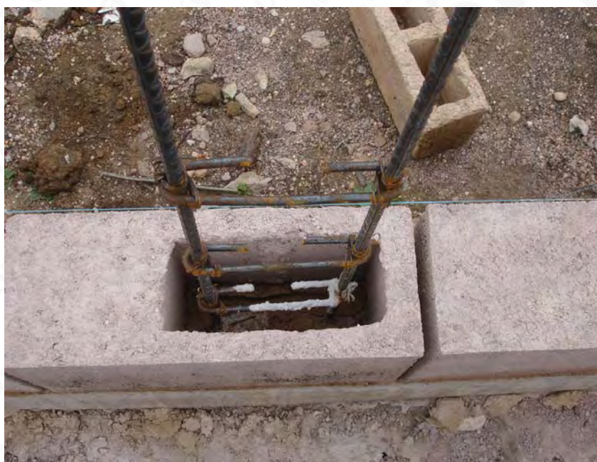
Castillo C-I con pieza especial B-7
