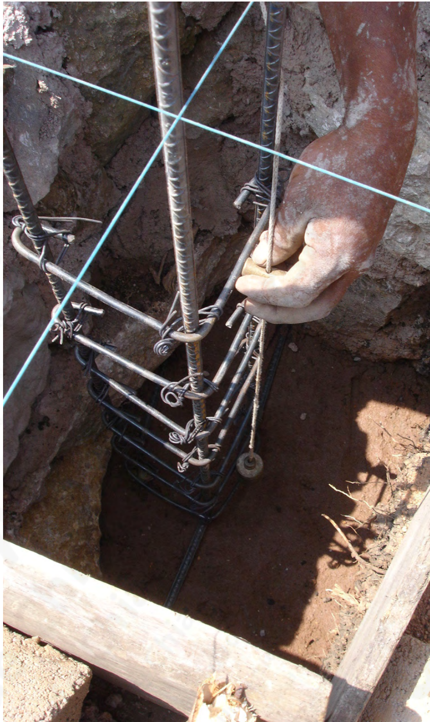
Anclaje de refuerzos verticales (Castillo C-L)
