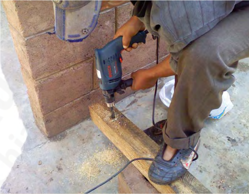
Perforación en polines para anclaje en cadenas
