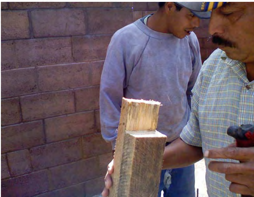
Corte para empalme de polines
