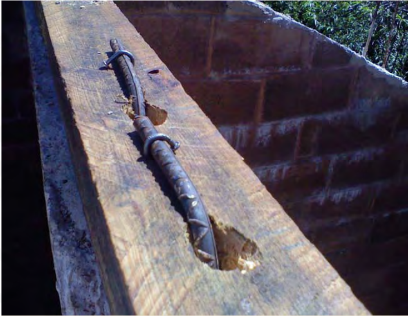
Polines anclados sobre cadena de enrase C-E (Caballete)
