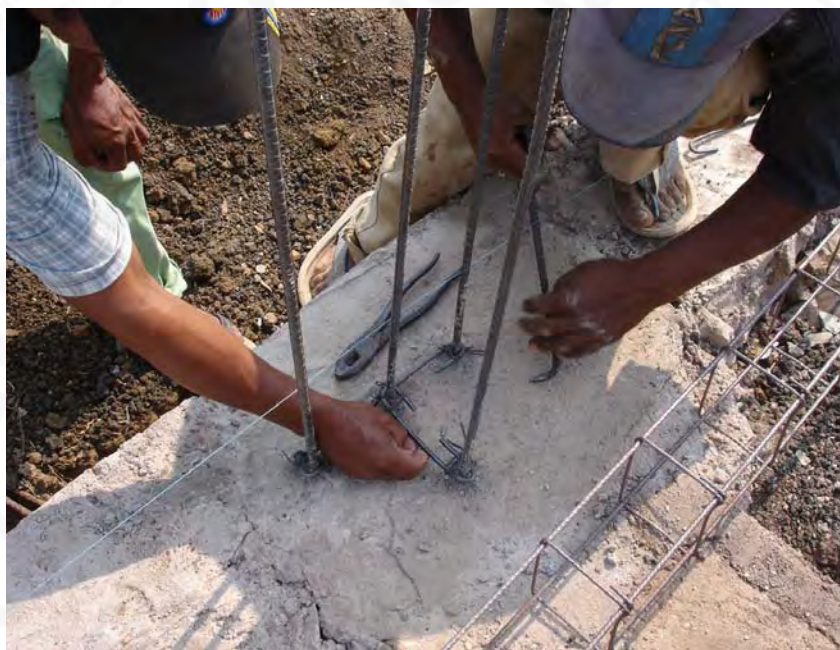
Estribos en castillos para colocación de armex
