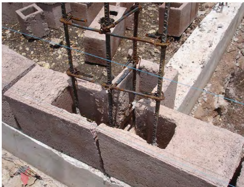
Encofrado de castillo C-T con piezas especiales B-10 y B-6
