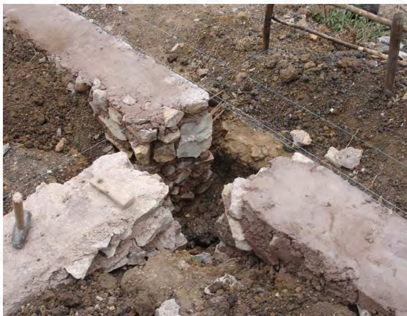
Preparación para anclar castillo C-T
