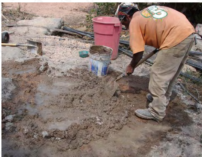
Concreto para colado de castillos en cimentación
