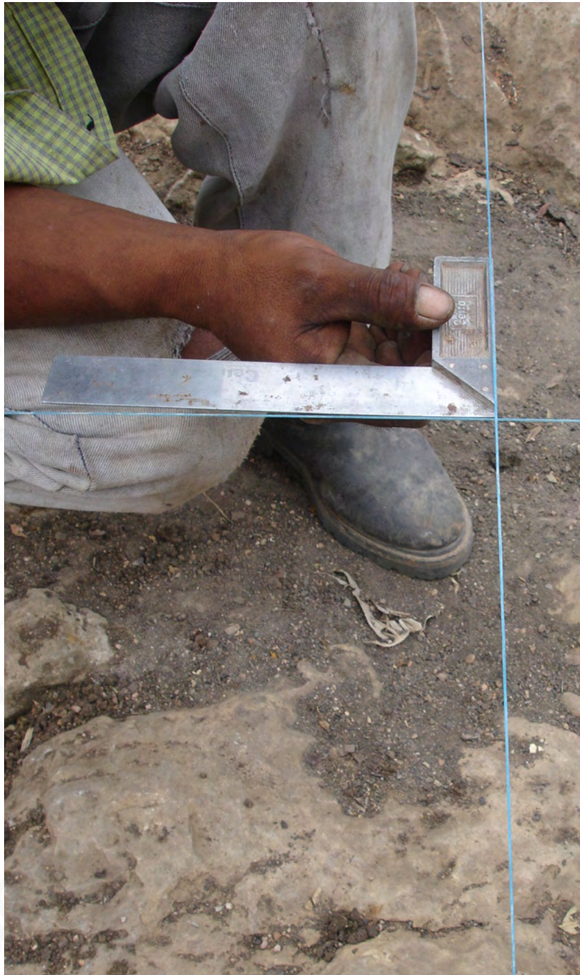
Verificación de ejes a escuadra
