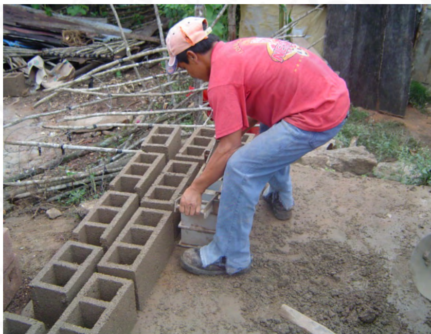
Retiro del molde (2)
