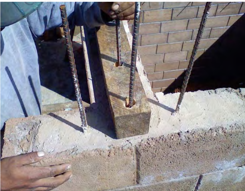
Colocación de polines sobre cadena de enrase C-E (Caballete)
