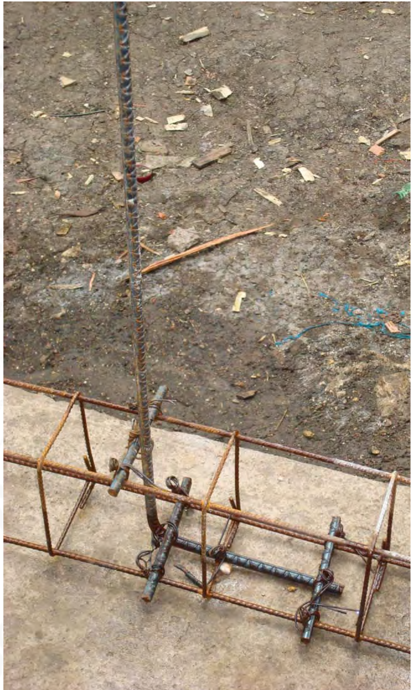
Refuerzo vertical adicional C-V en cadena de desplante
