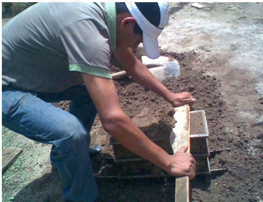
Retiro de la mezcla excedente
