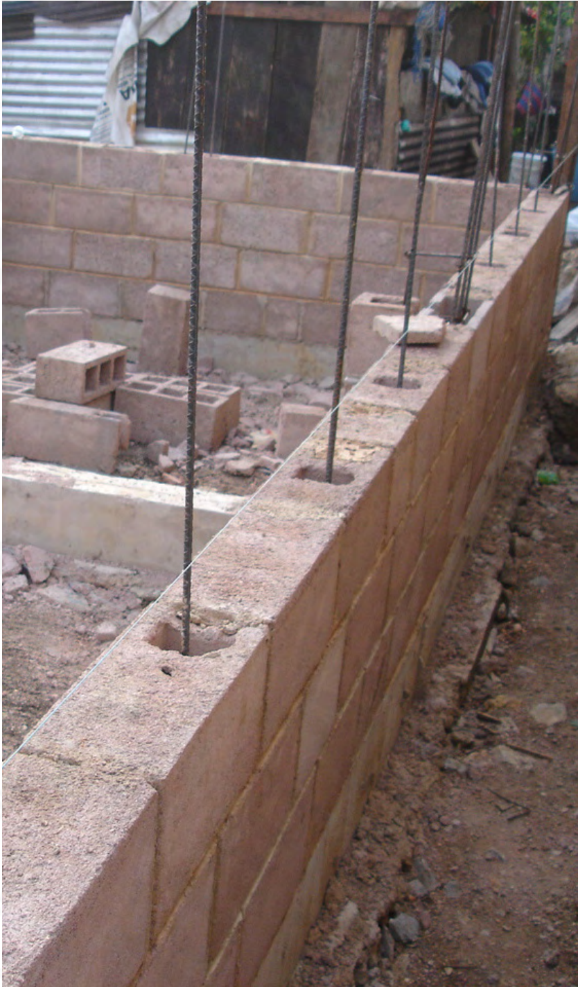
Muro de block y castillos C-V
