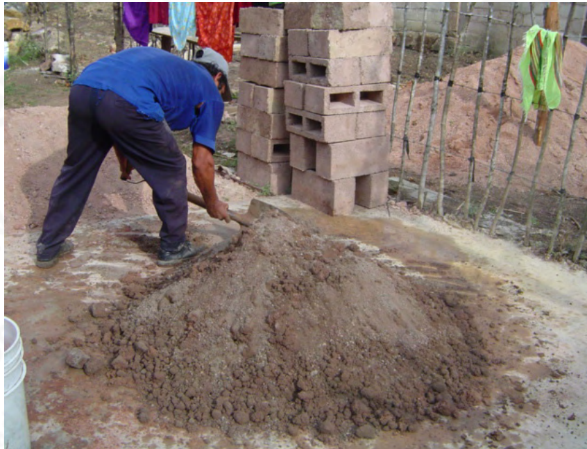
Mezcla para block hueco (1)
