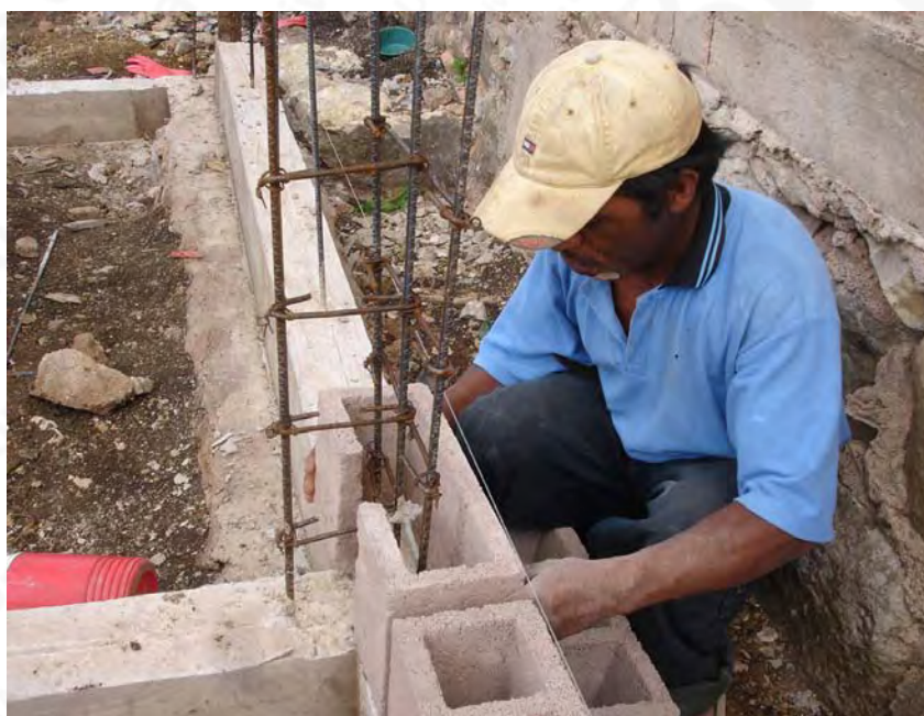
Encofrado de castillo C-T con piezas especiales
