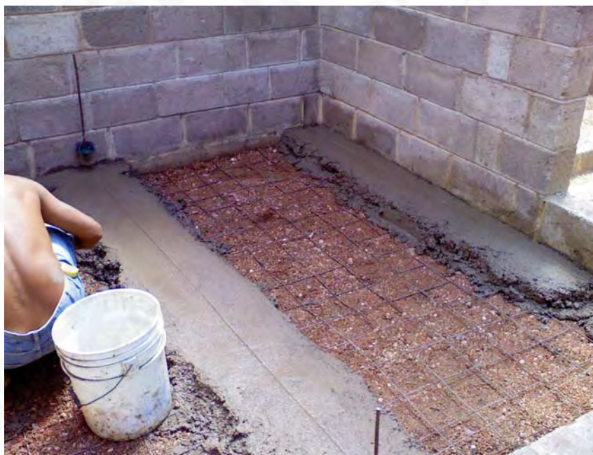
Franjas de concreto para guías durante el colado
