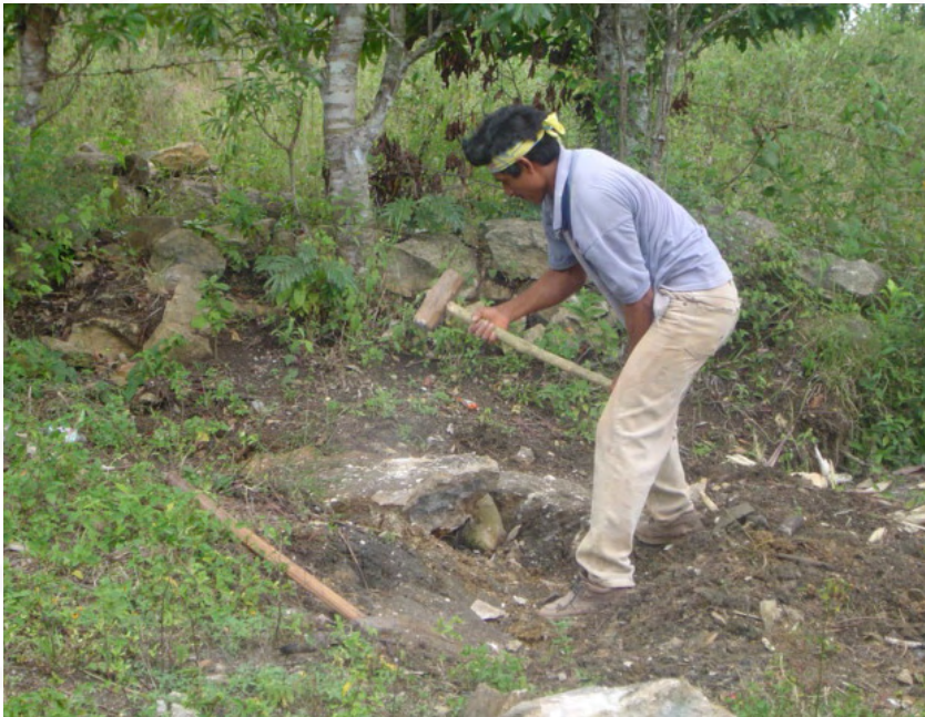
Extracción de piedra del lugar con pico y mazo
