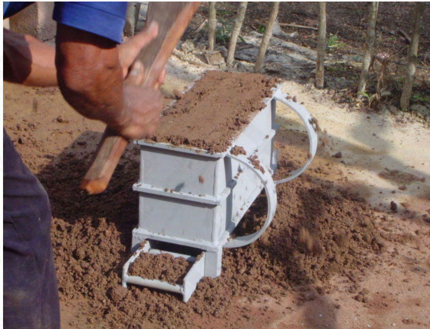
Compactado de la mezcla en el molde
