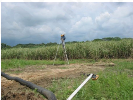
Figura 40. Instalación del emisor de rayo láser con la pendiente del colector
