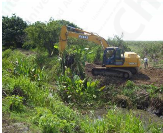
Figura 33. Construcción y adecuación de dren
