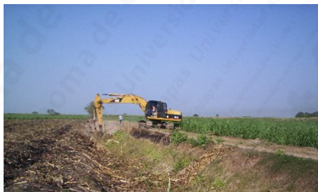
Figura 34. Mantenimiento del dren
