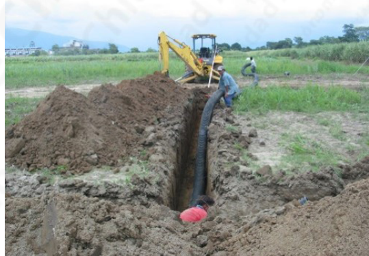
Figura 41. Instalación de colectores
