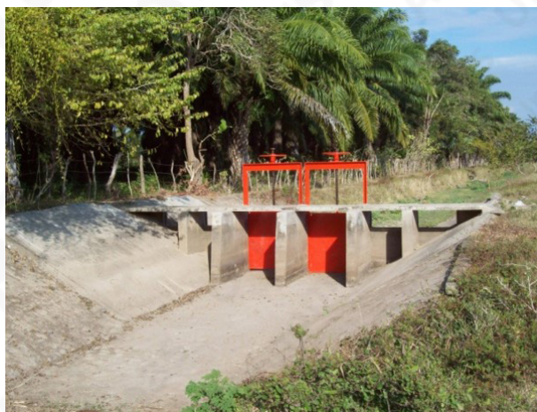
Figura 39. Estructura de control con compuertas y vertedores
