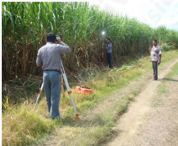
Figura 32. Replanteo de dren
