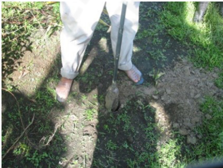
Figura 2. Perforación de pozos de observación
