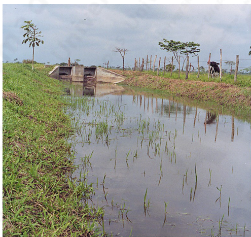
Figura 38. Acondicionamiento de alcantarilla como estructura de control
