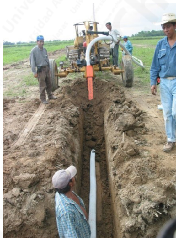
Figura 42. Instalación de un dren lateral
