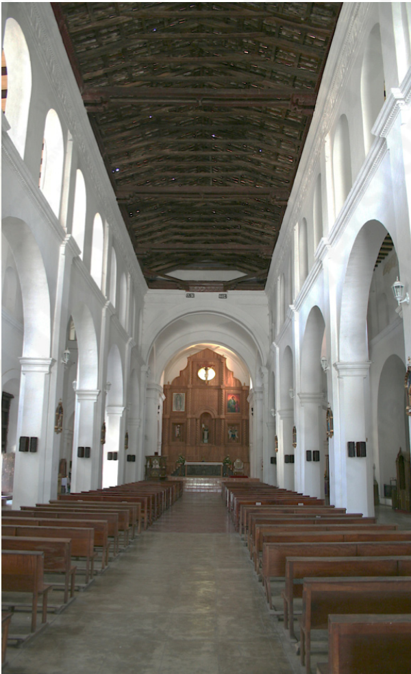
Figura 12. Templo de Santo Domingo de Guzmán en Chiapa de Corzo con tres naves y techumbre de madera a dos aguas.
