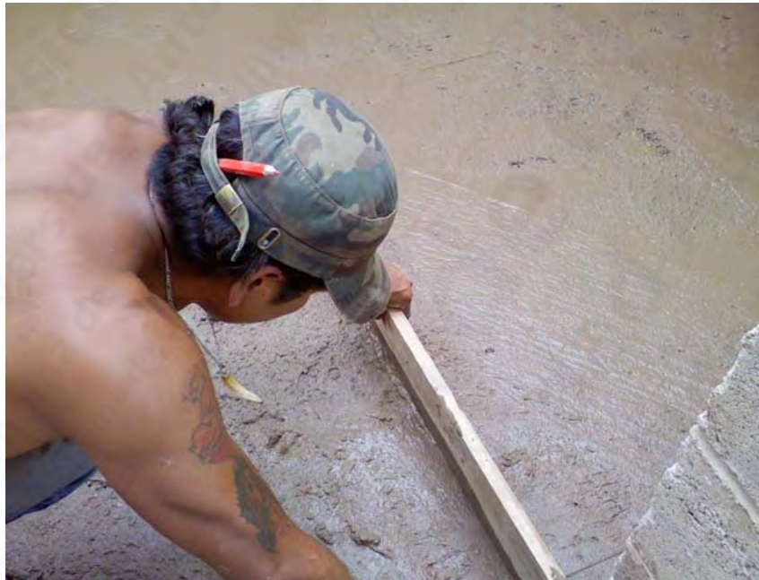
Aplanado de concreto en piso
