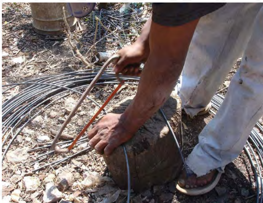
Alambrón para anillitas de castillos
