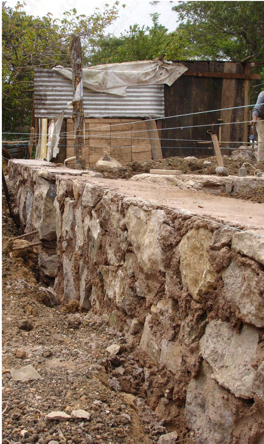
Cimentación de mampostería de piedra
