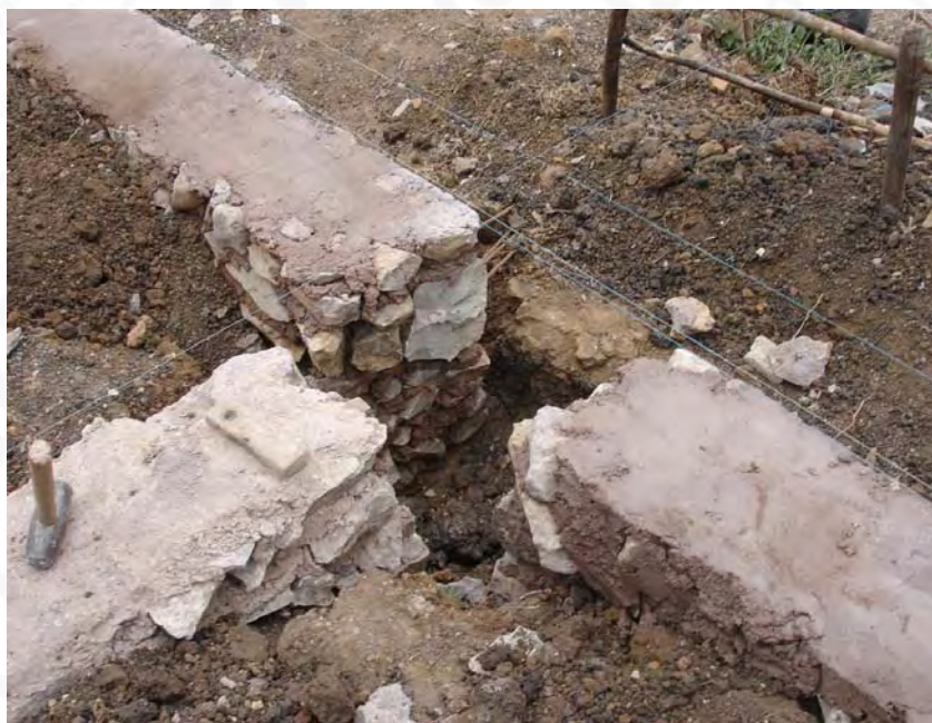
Preparación para anclar castillo C-T
