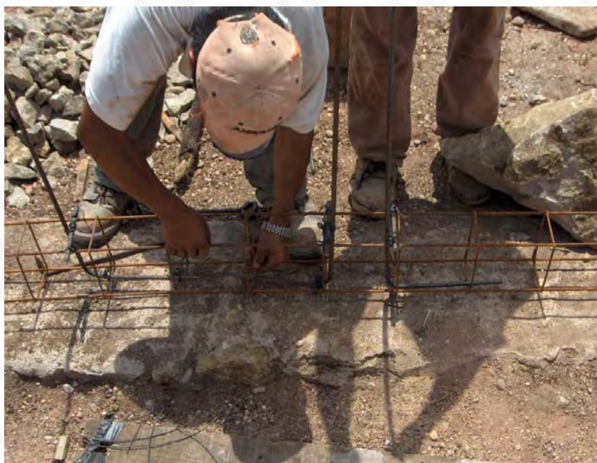
Colocación de refuerzo vertical C-I en cadena de desplante
