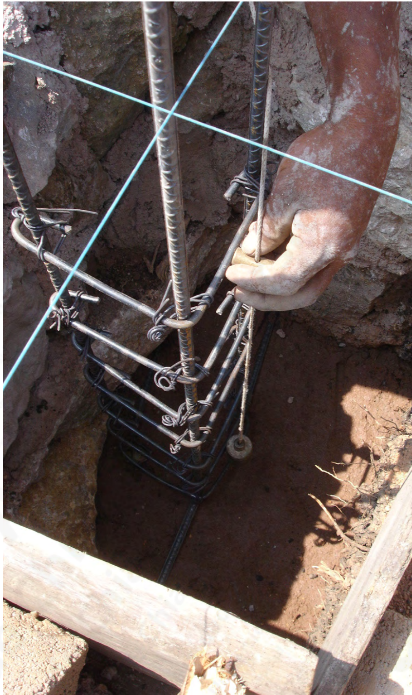
Anclaje de refuerzos verticales (Castillo C-L)
