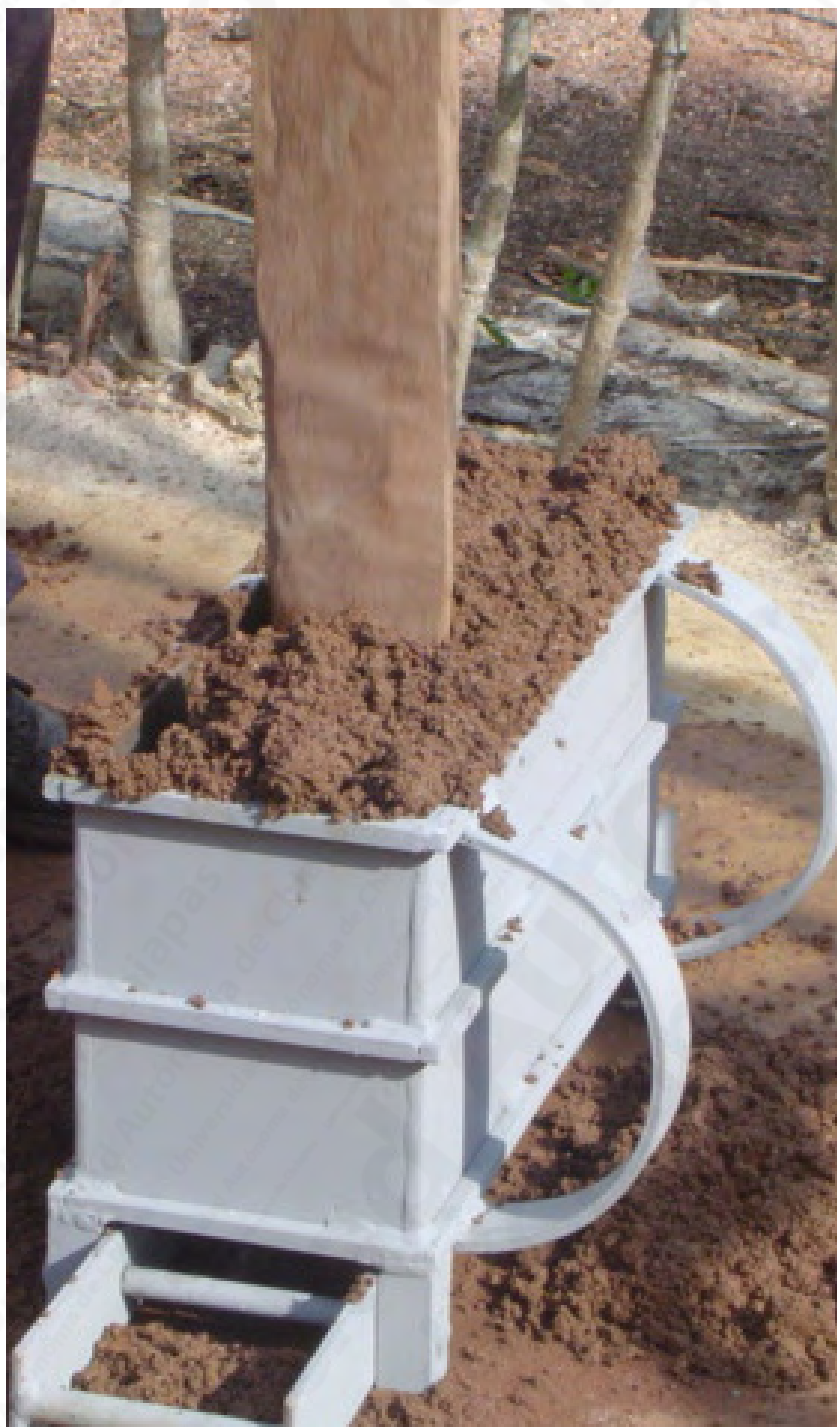
Llenado del molde y apisonado de la mezcla
