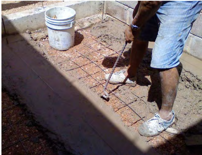
Levantado de malla electrosoldada durante el colado
