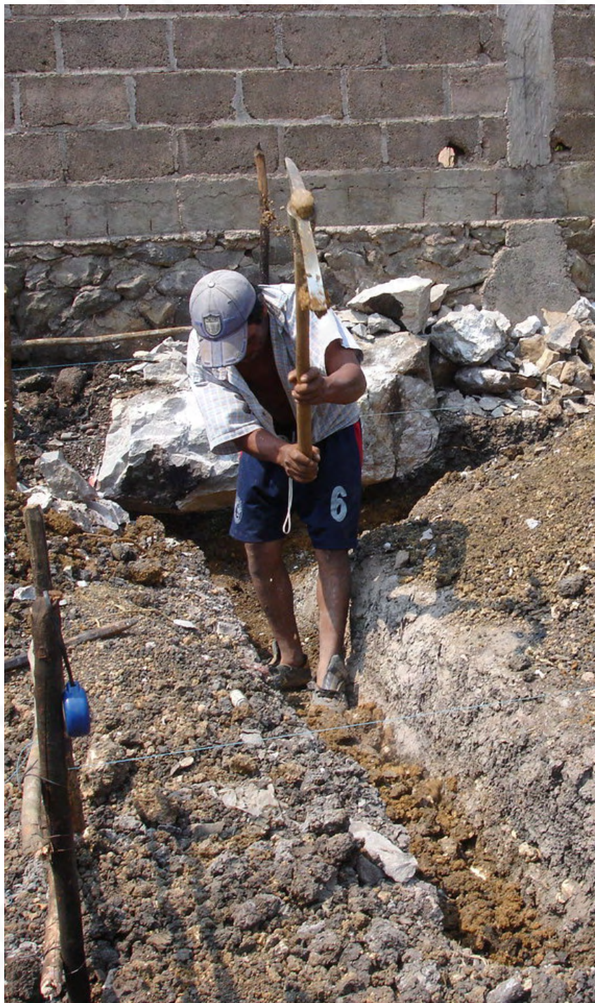
Excavación para cepa de cimentación
