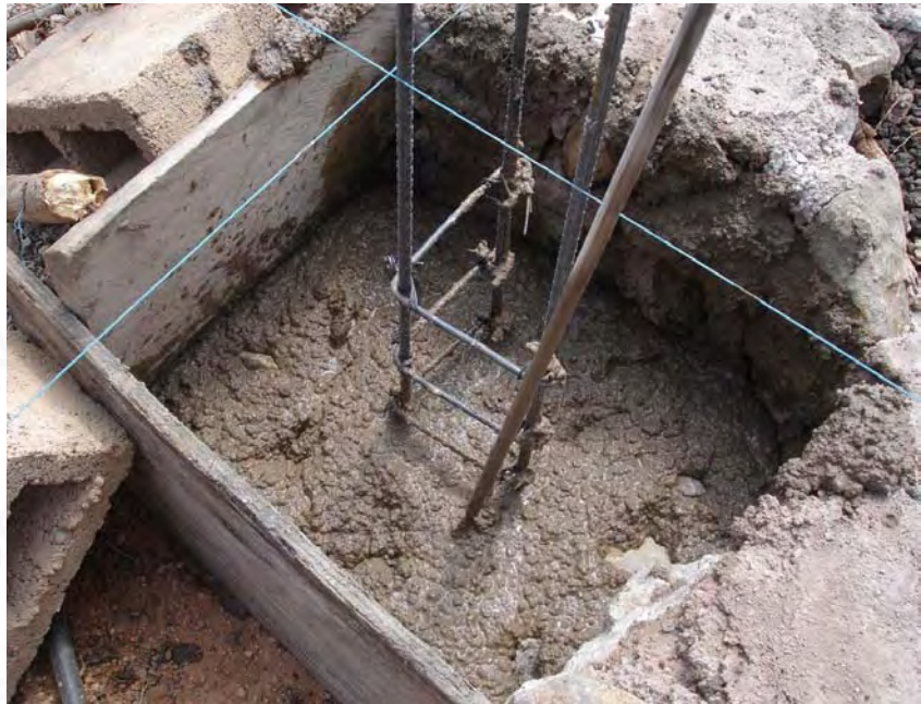
Picado de concreto a mano con varilla metálica de 3/8"
