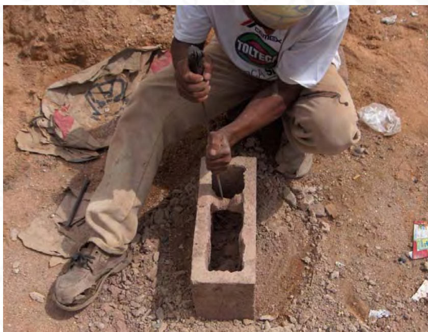
Elaboración de piezas especiales en seco (2)
