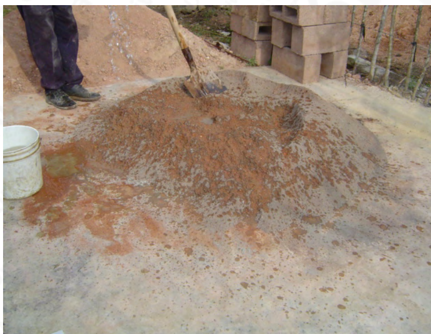
Mezcla para block hueco (verificación de la cantidad de agua)
