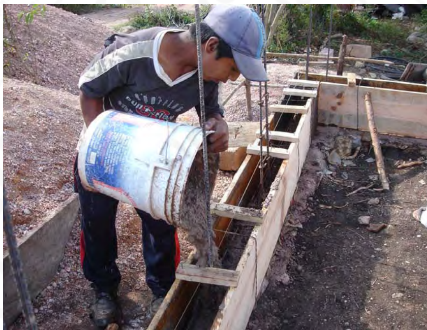
Colado de cadena de desplante
