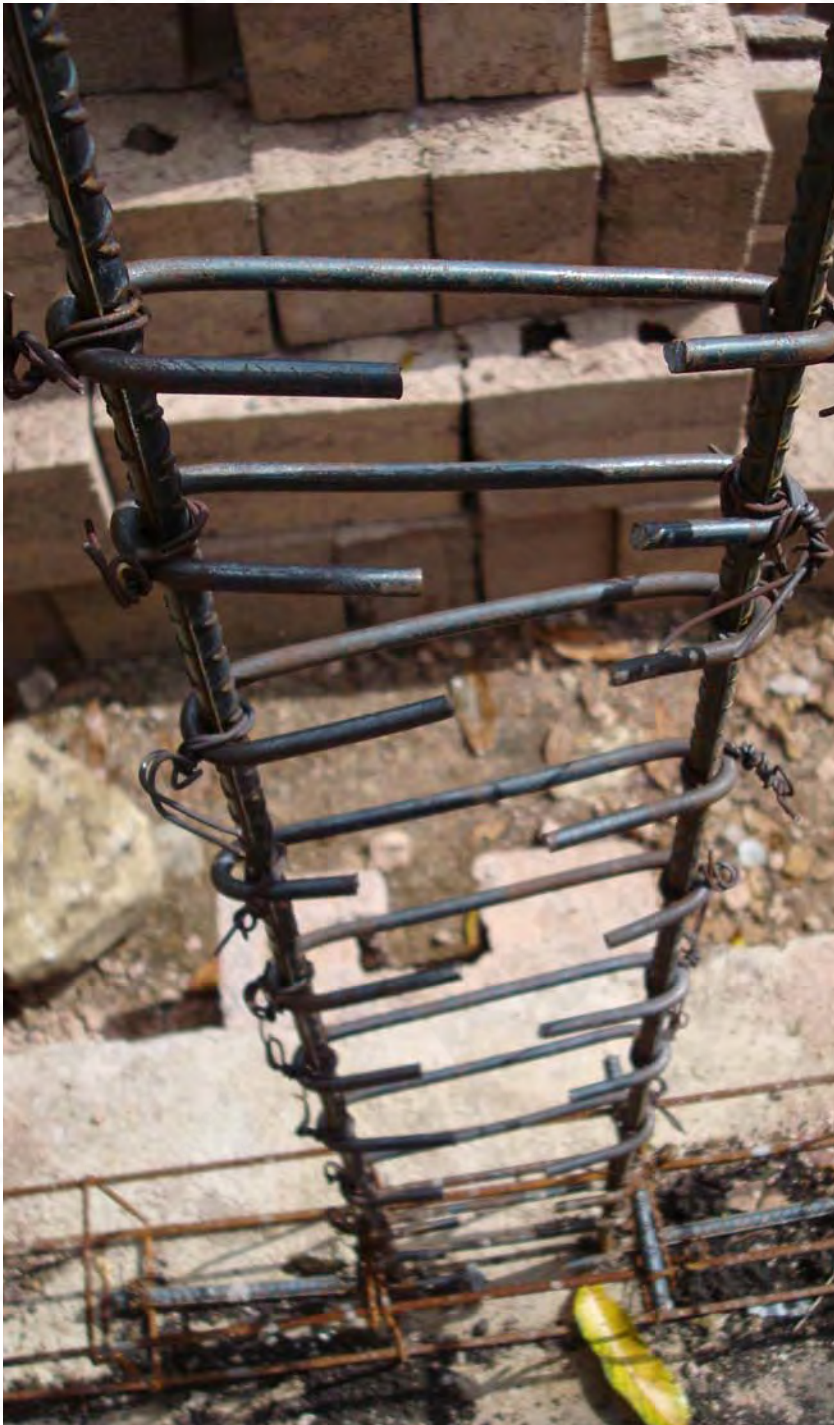
Refuerzo vertical (Castillo C-I)
