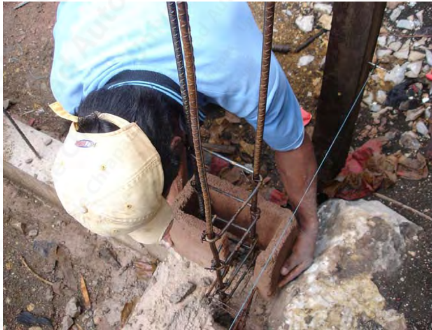
Colocación de pieza especial B-13 en castillo C-L
