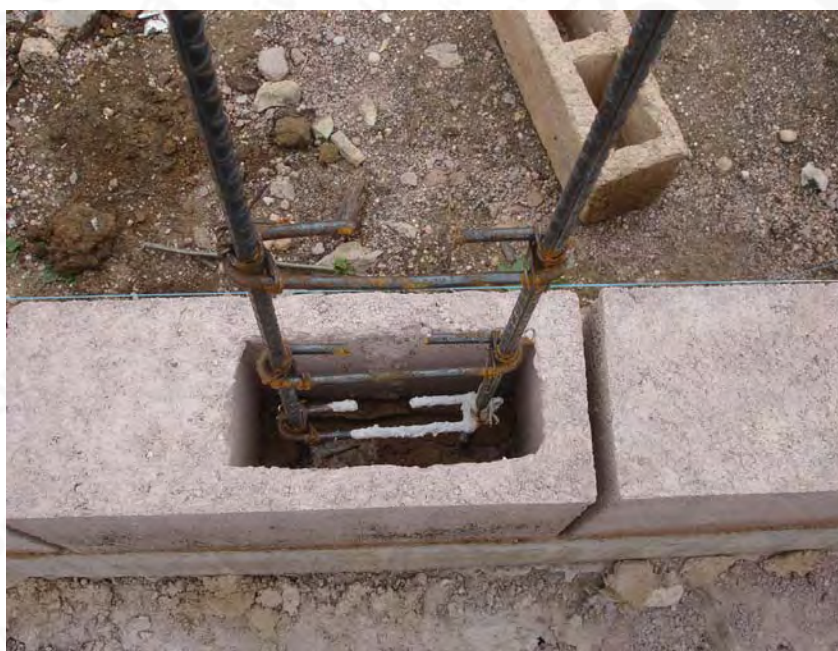
Castillo C-I con pieza especial B-7
