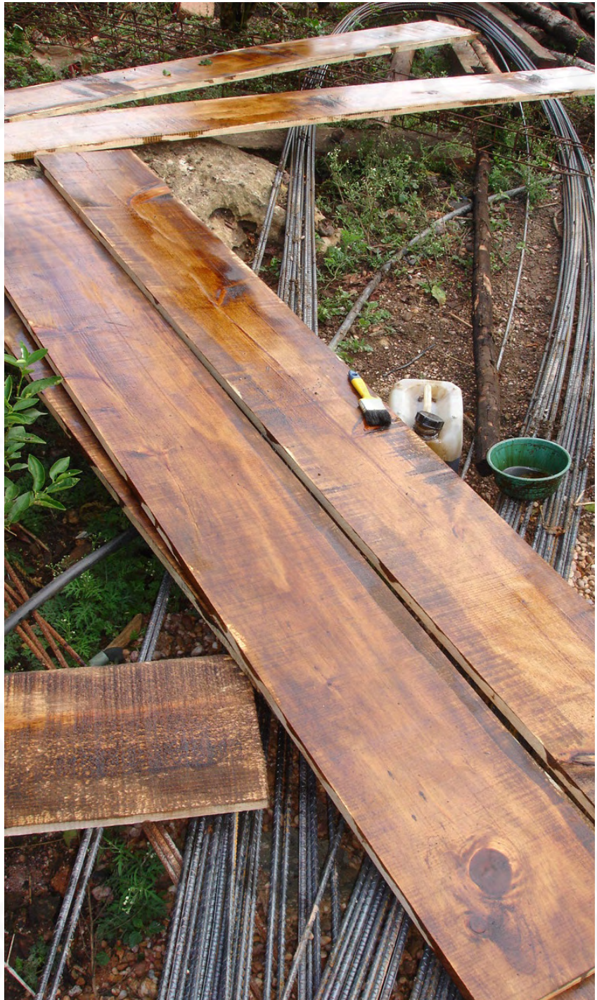
Cimbra de madera curada con aceite quemado
