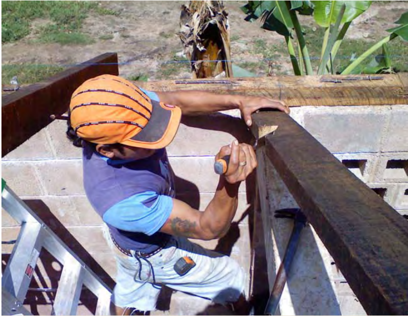
Ajuste de muesca en barrote para anclaje en polín
