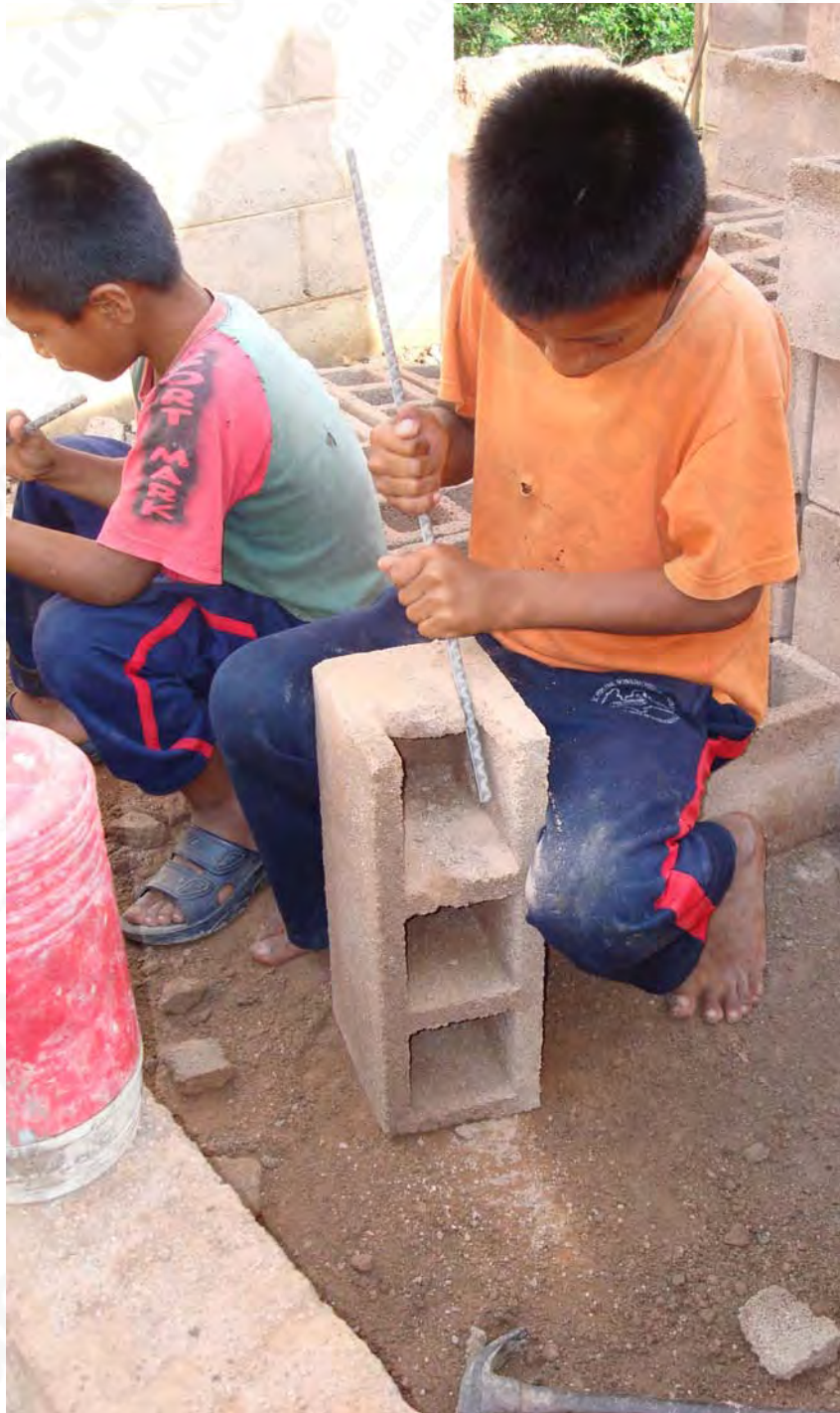
Elaboración de piezas especiales en seco (Pieza B-2)
