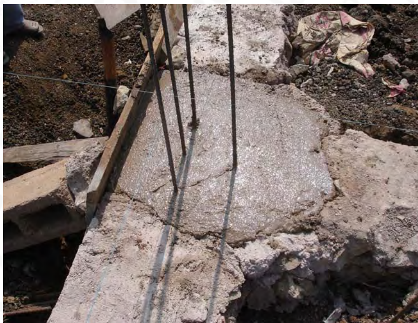
Castillo C-T colado completamente
