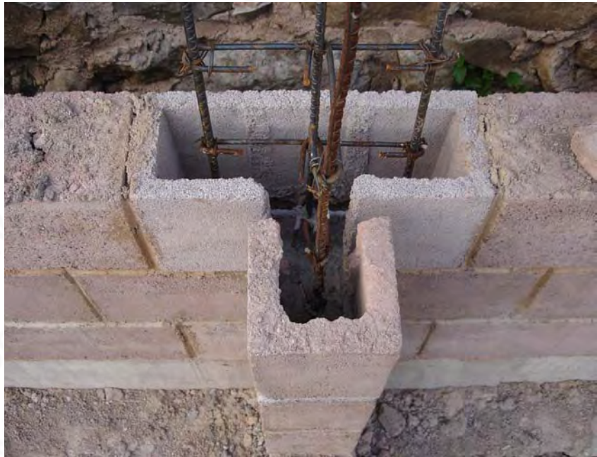
Encofrado de castillo C-T con piezas especiales B-9 y B-6
