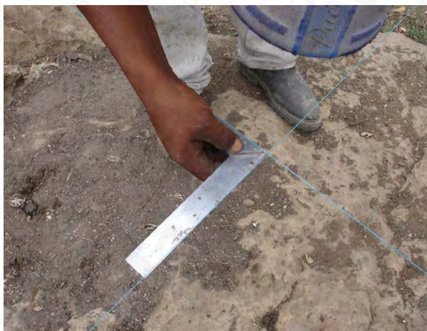
Comprobación de trazo de ejes a escuadra (Ejes 1-A)
