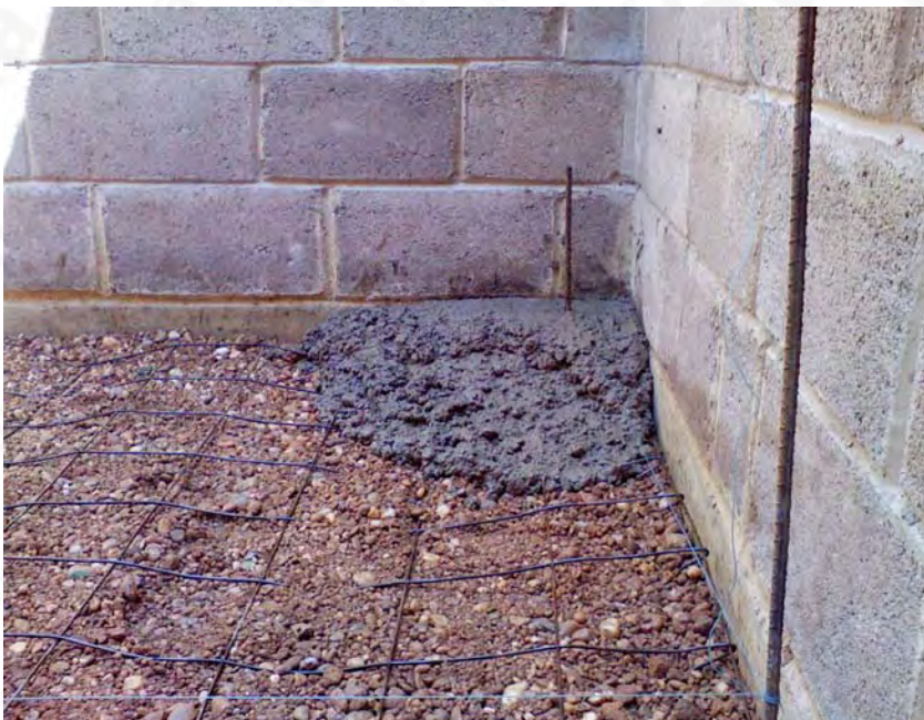
Tendido de concreto para firme
