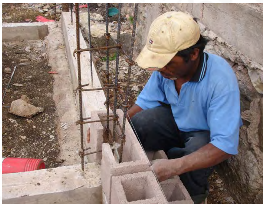
Encofrado de castillo C-T con piezas especiales
