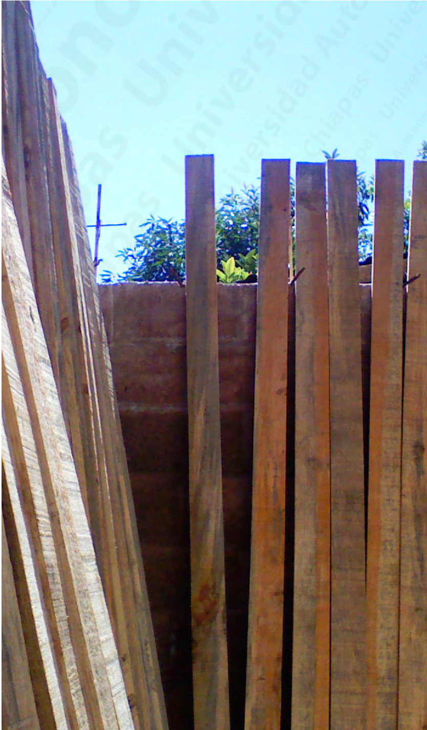
Reglas de madera de 2.5x10 cm para soporte de teja de barro
