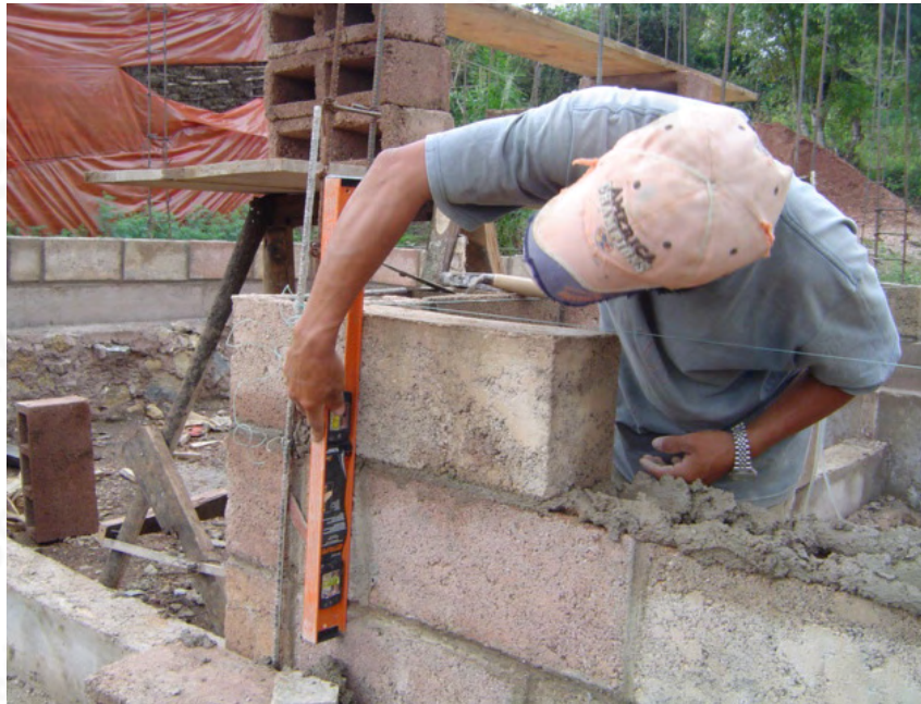
Verificación de plomo en muro
