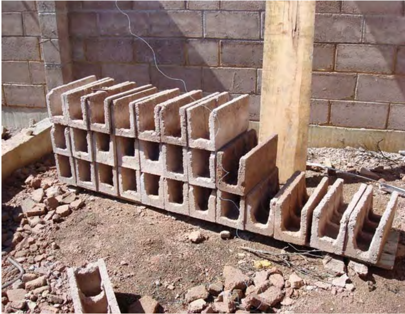
Canal para refuerzo vertical horizontal intermedio CC-I
