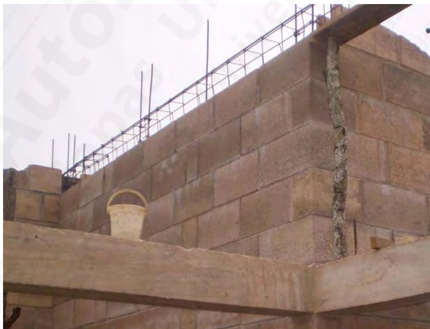
Colocación de armex para cadena de enrase C-E en caballete
