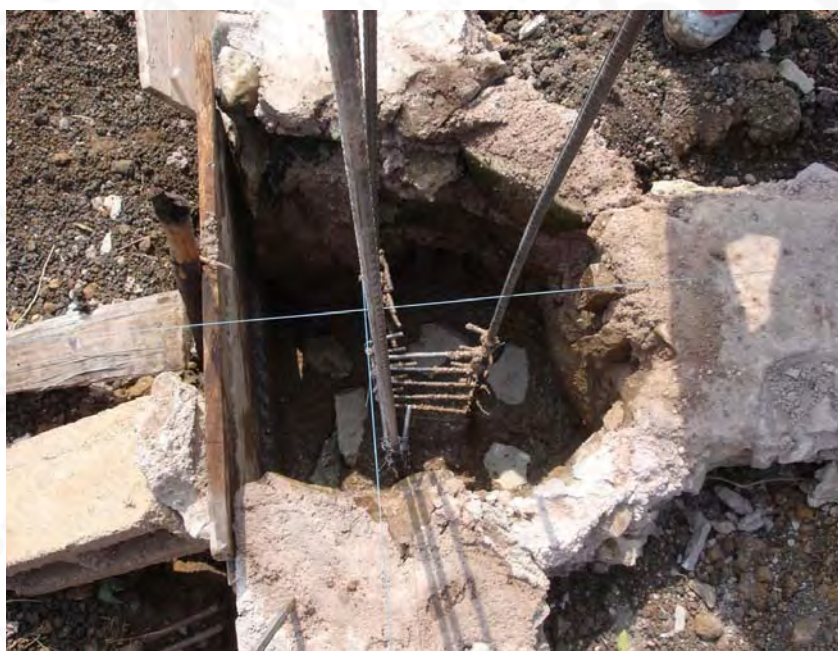
Colado de castillo C-T con concreto ciclópeo
