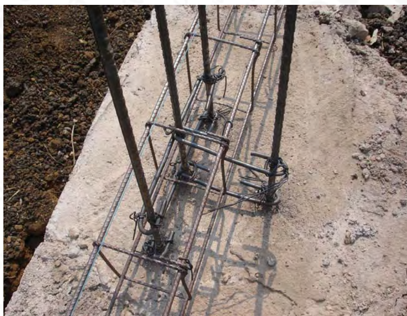
Colocación de armex para cadena de desplante
