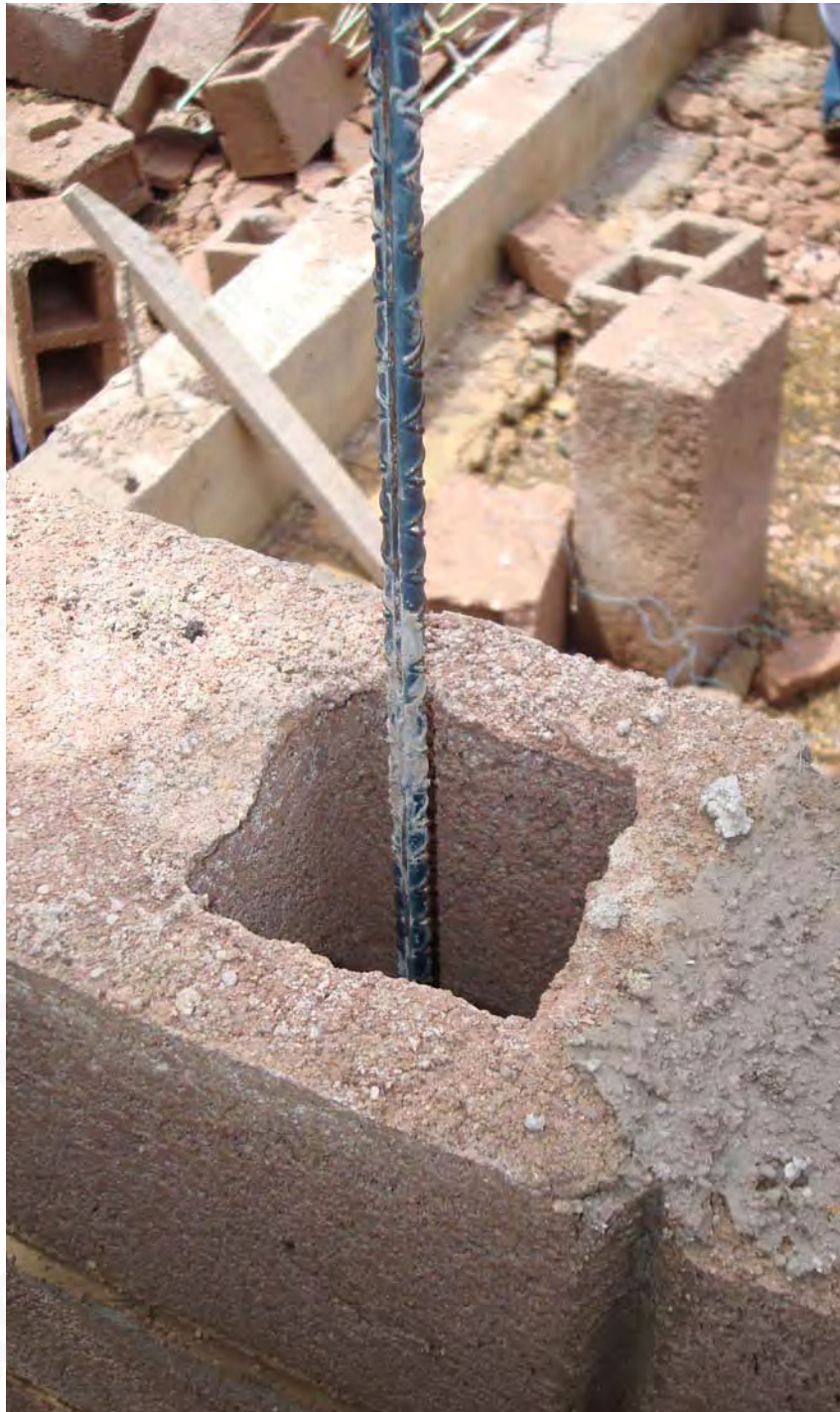
Castillo C-V ahogado en pieza especial de block
