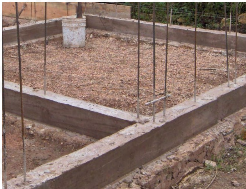
Cadena de desplante terminada
