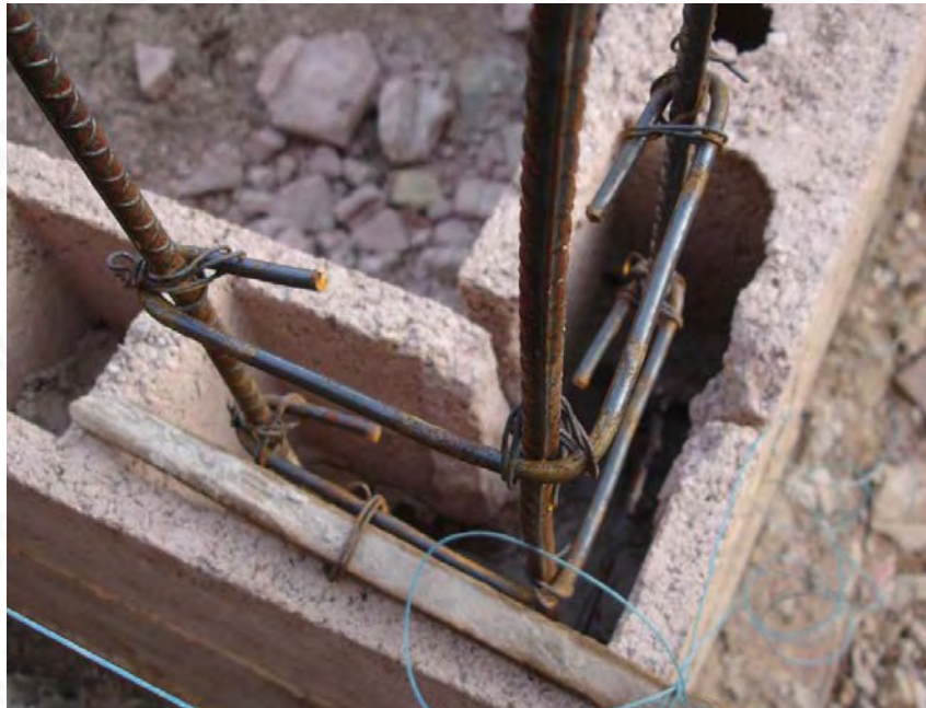
Piezas especiales de block castillo C-L
