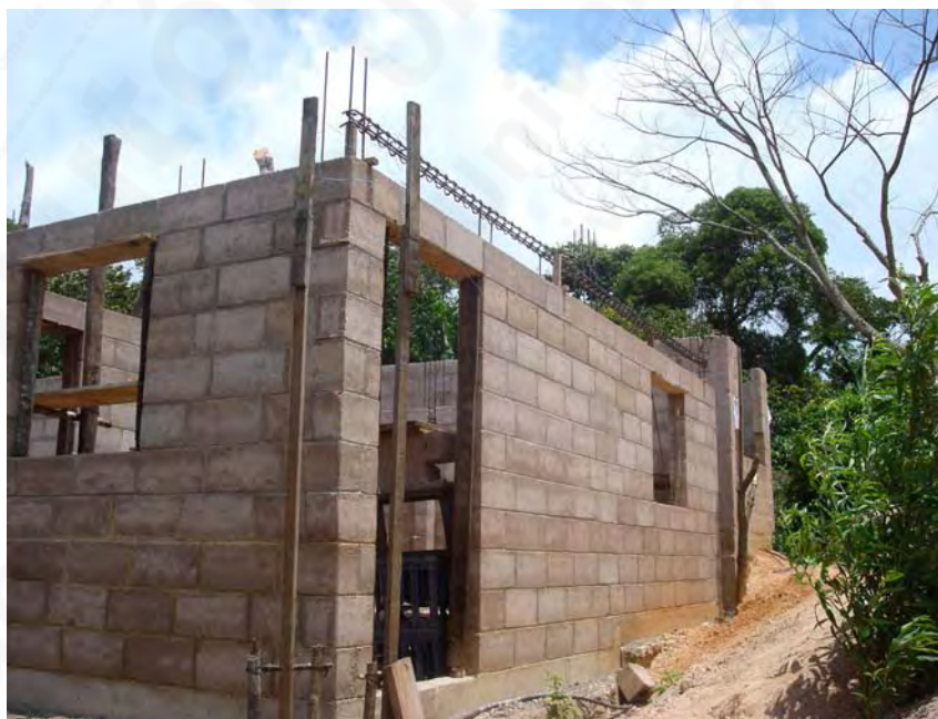
Colocación de cadena de cerramiento CC-2
