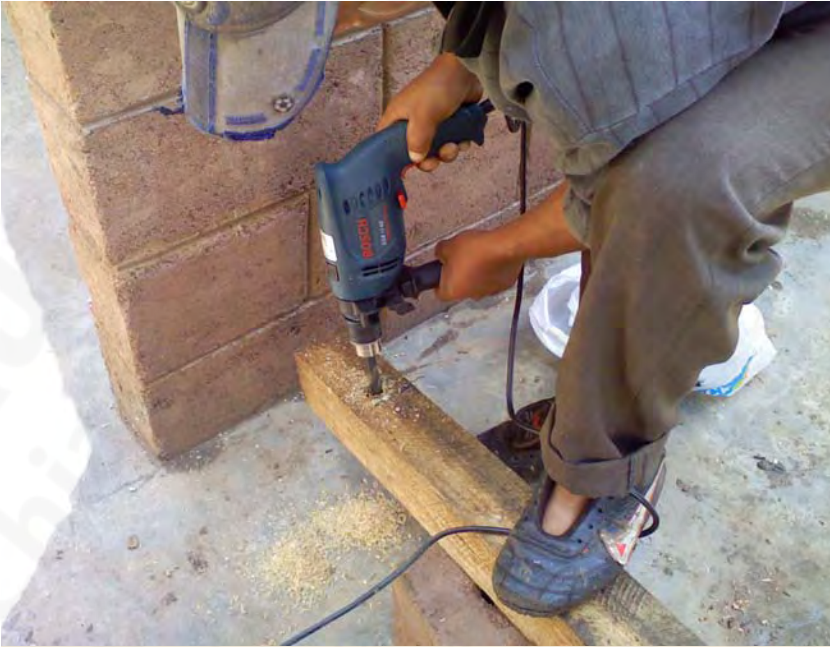
Perforación en polines para anclaje en cadenas
