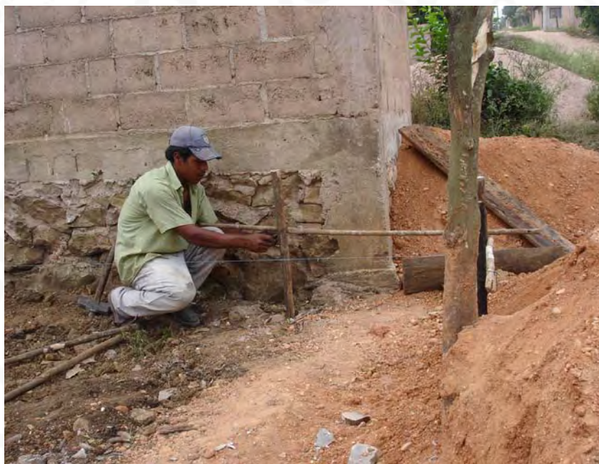
Elaboración de puentes para la colocación del reventón
