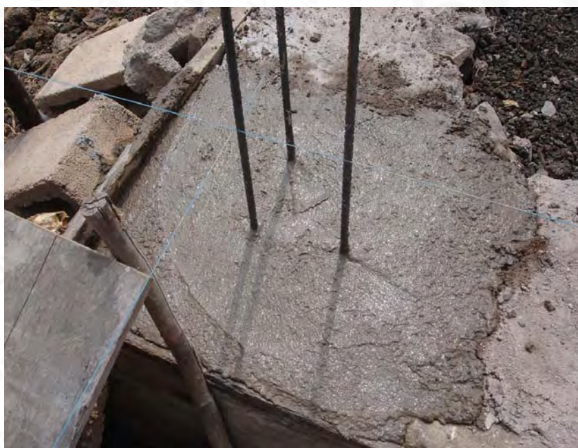
Castillo C-L colado completamente
