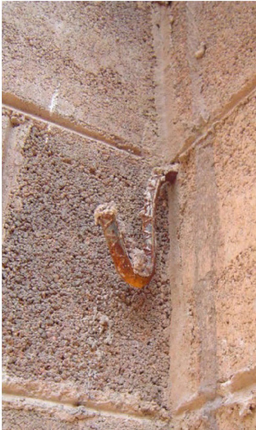
Gancho para hamaca, anclado a cadena de cerramiento CC-2
