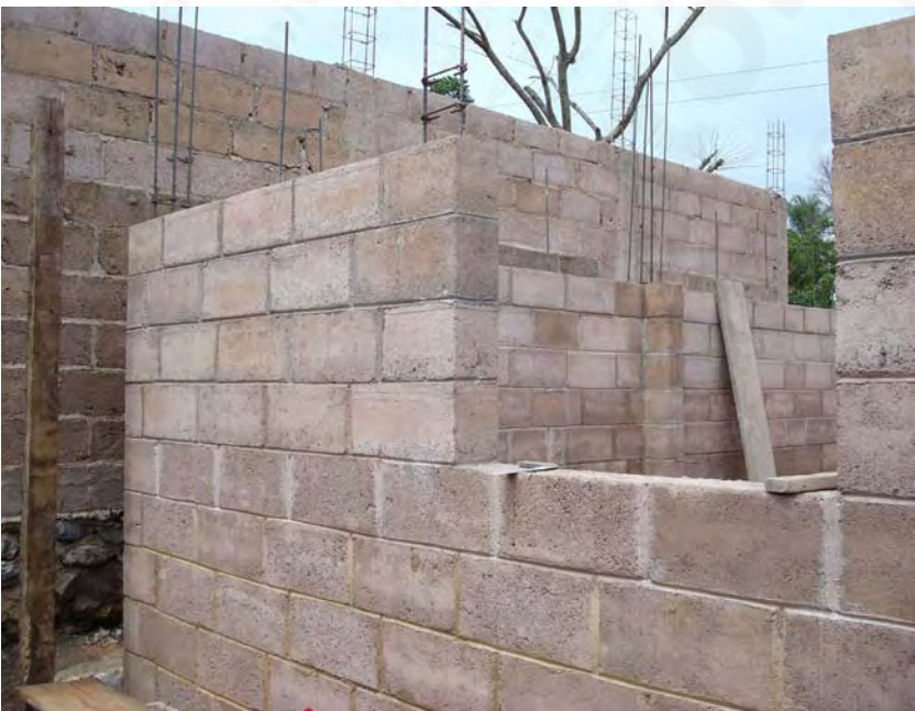
Vano en muro para ventana
