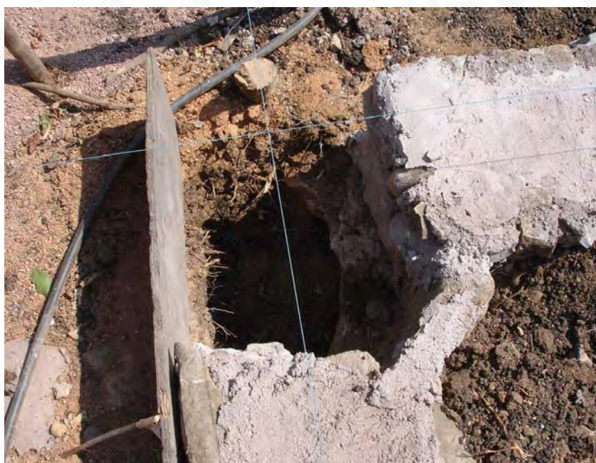
Preparación para anclar castillo C-L
