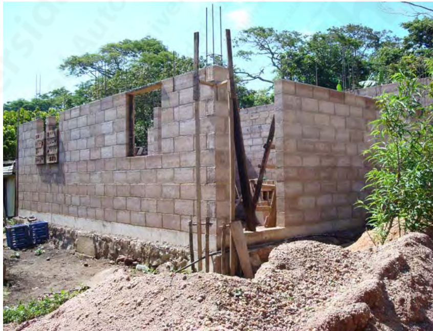
Cimbra en vanos de puertas y ventanas
