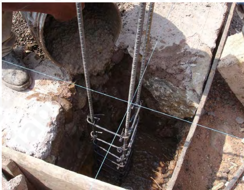
Colado de castillo C-L con concreto ciclopeo
