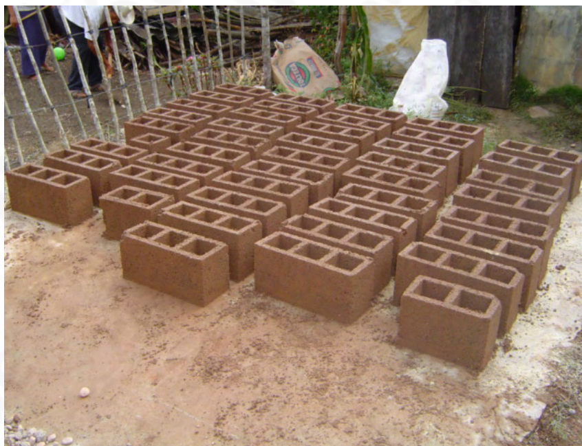
Tendido del block para su secado
