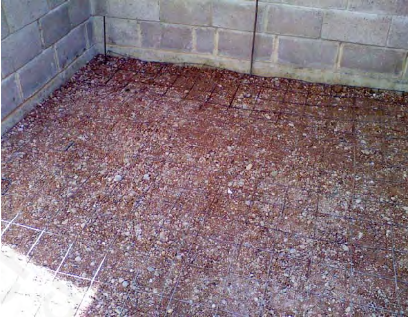
Colocación de malla electrosoldada para firme
