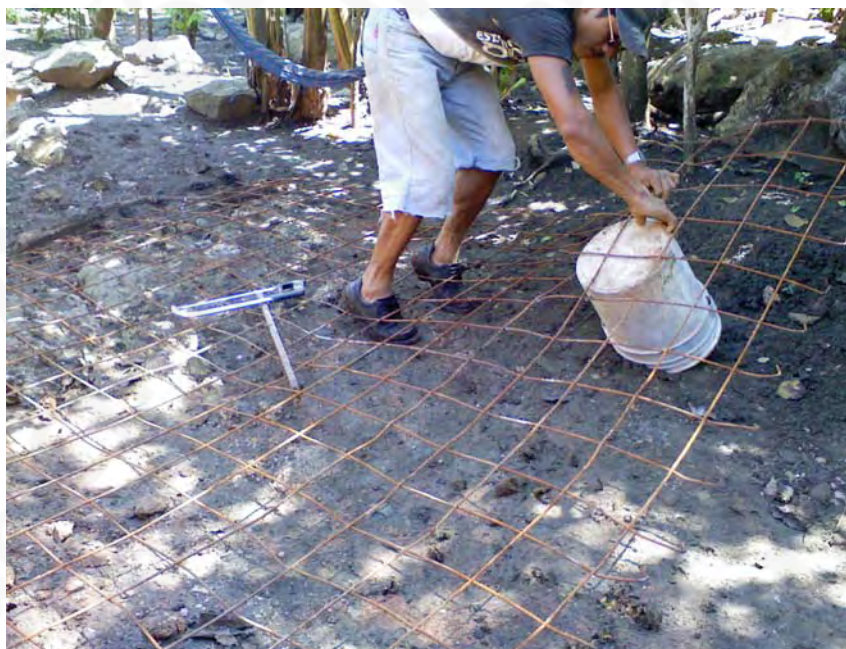
Preparación de malla electrosoldada 6-6/10-10 para firme
