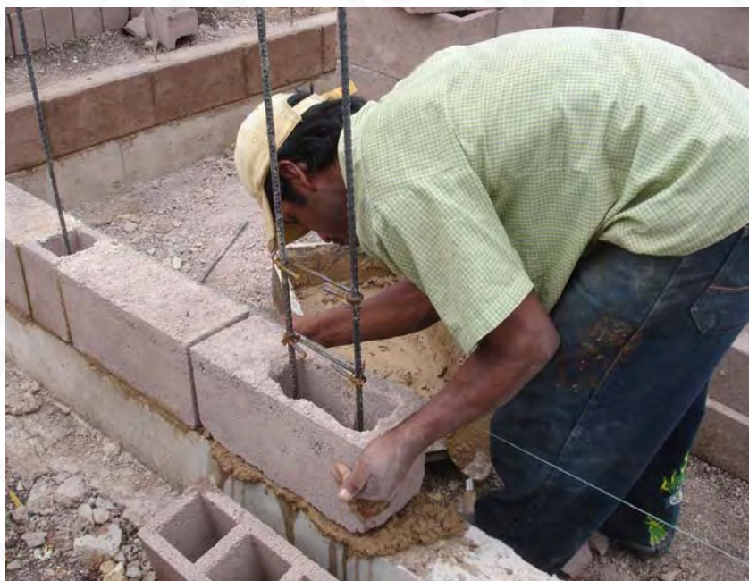
Pegado de pieza especial B-7 para castillo C-I
