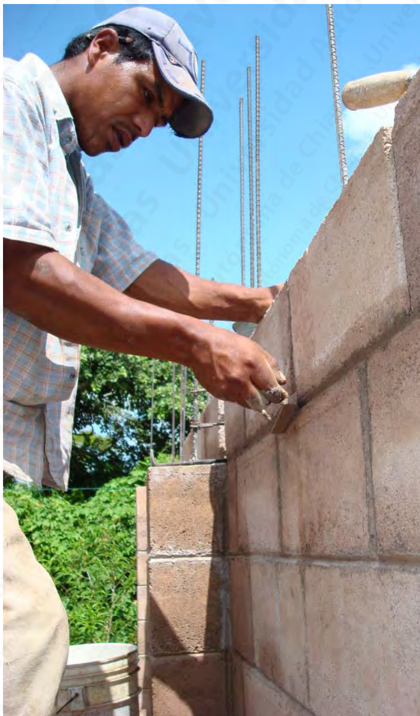
Sr. Crecencio Pérez, trabajando en los muros de su vivienda
