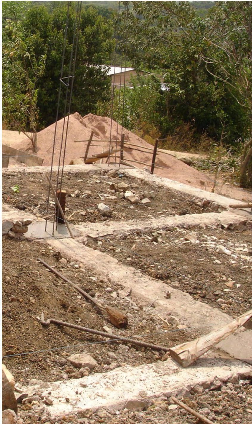
Cimentación terminada con la totalidad de castillos colados
