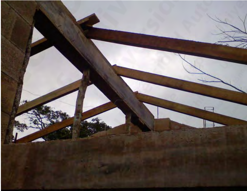
Barros colocados en cadena de enrase C-E
